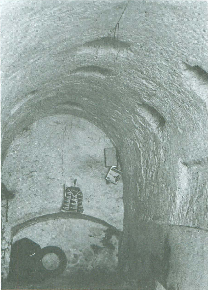
Fot. 2. CHINCHILLA. Baños árabes. Interior de la nave "A". Obsérvense los lucernarios estrellados, así como el hueco cegado de la derecha.
