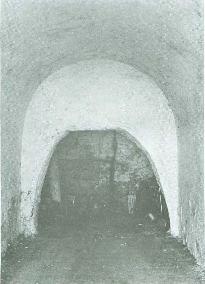
Fot. 4. CHINCHILLA. Baños árabes. Interior de la nave "B". Al fondo el acceso a la nave transversal.
