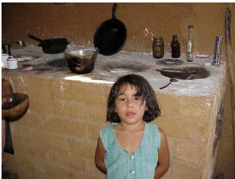
Foto 7. Fogón de leña mejorado, construido con adobe de barro prensado en Paujicito, municipio Torres, Estado Lara. Fuente: Proyecto PROSALAFa.
