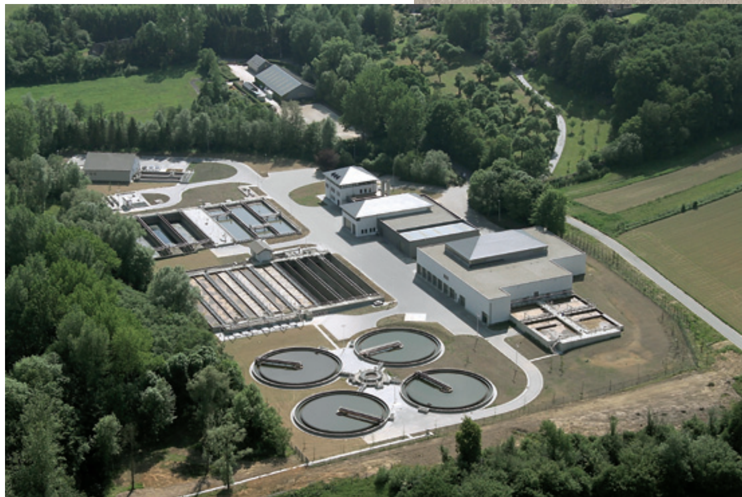
Station d'épuration de la Lasne à Rosières - IBW
