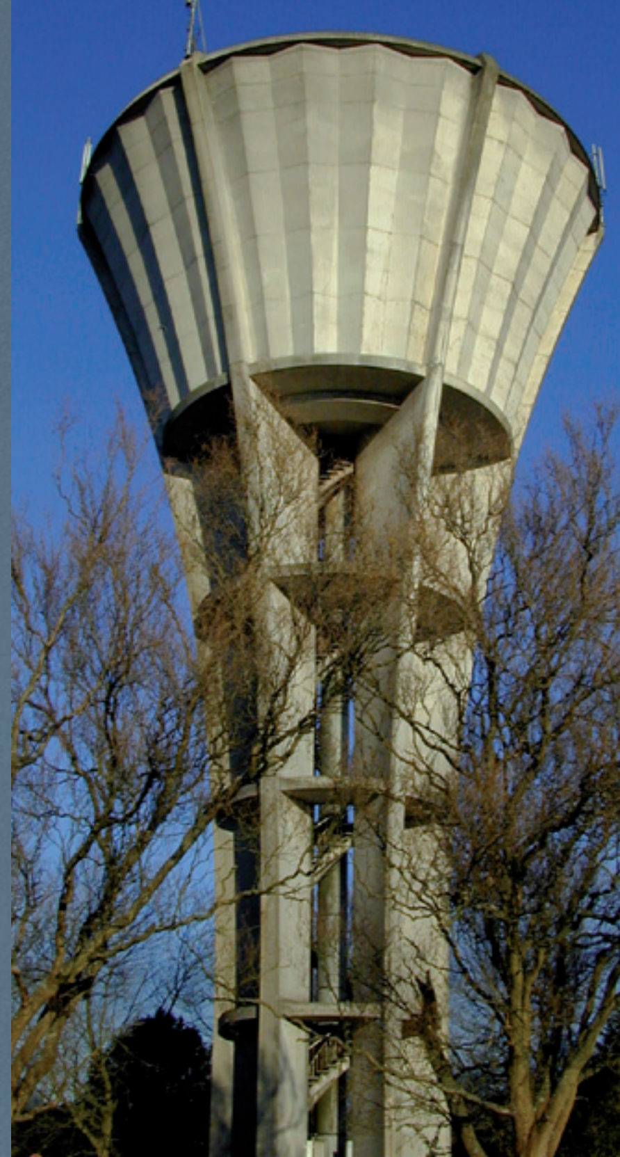
Château d'eau de Genval
