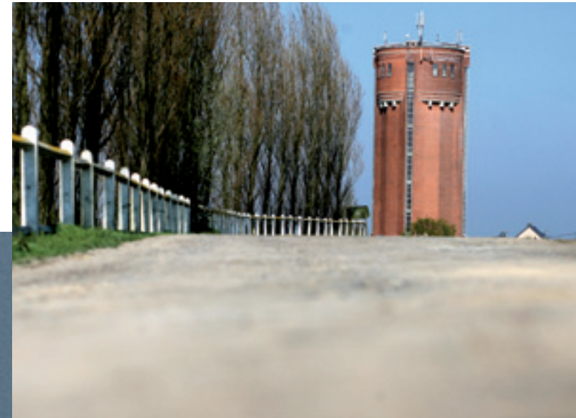
Château d'eau de Sart-Dames-Avelines
