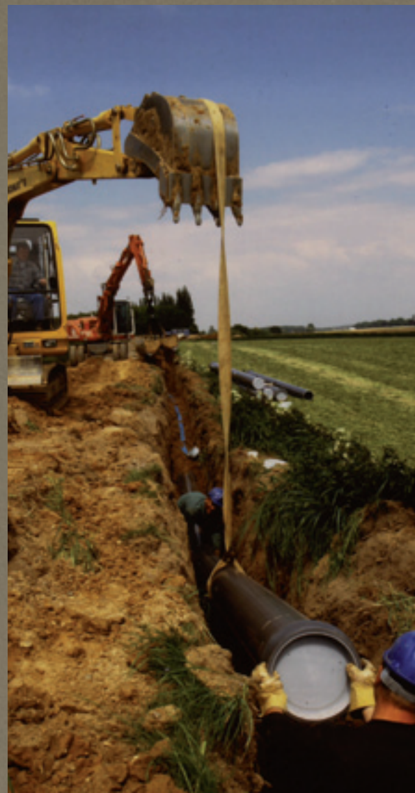
Prolongation de la conduite du Grand Chemin vers Rixensart
