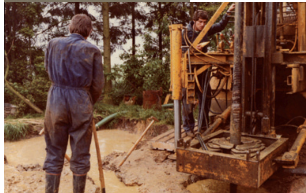
Forage d'un puits à Céroux-Mousty
