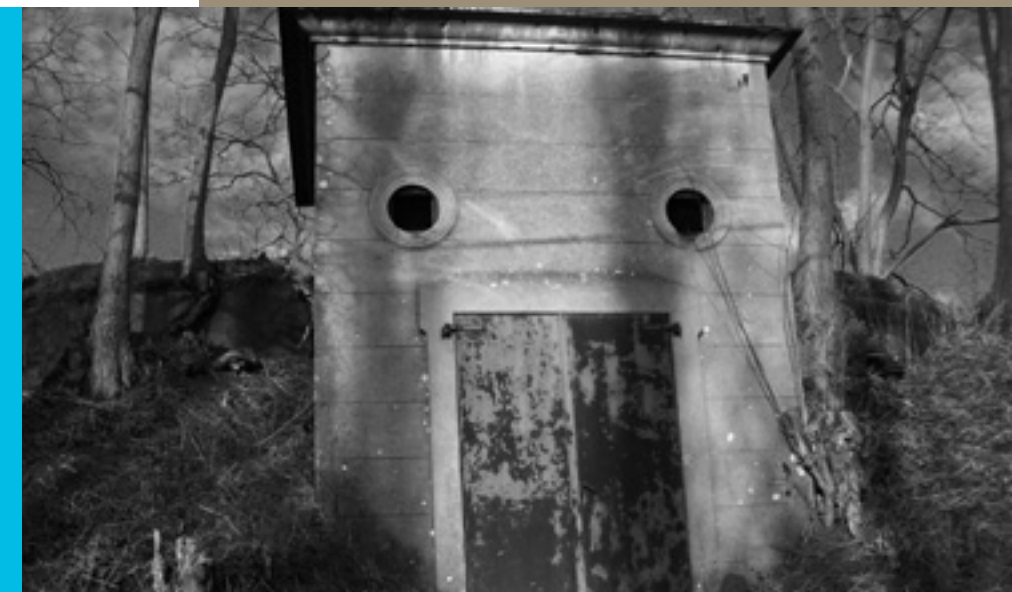
Ancien réservoir de Glabais
