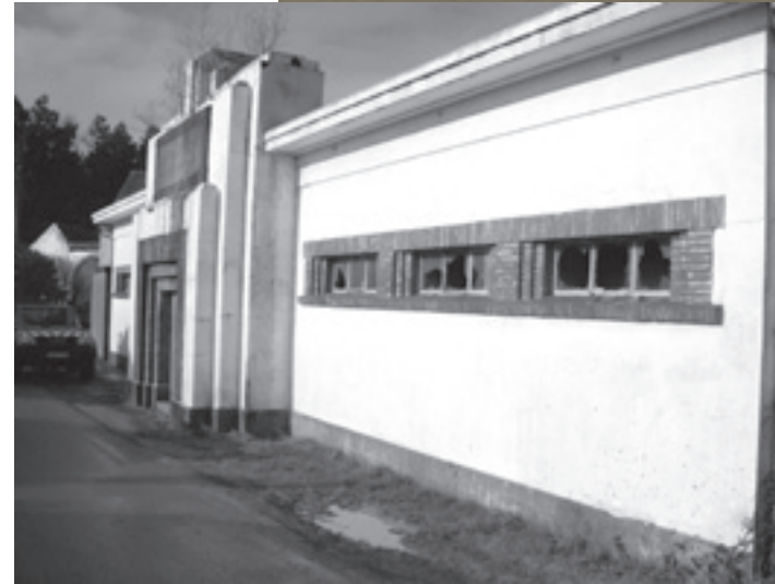
Ancien réservoir de Beurieux
