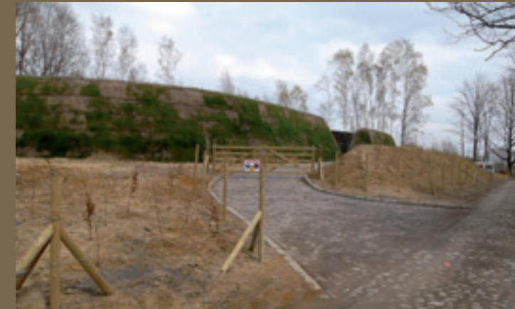
Réservoir d'eau à Ohain, chemin du Pêque
