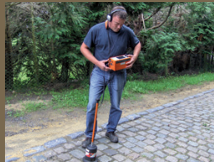
Recherche de fuite
