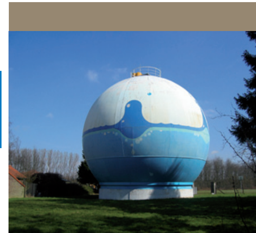
Réservoir de Bierges : "La Boule"
