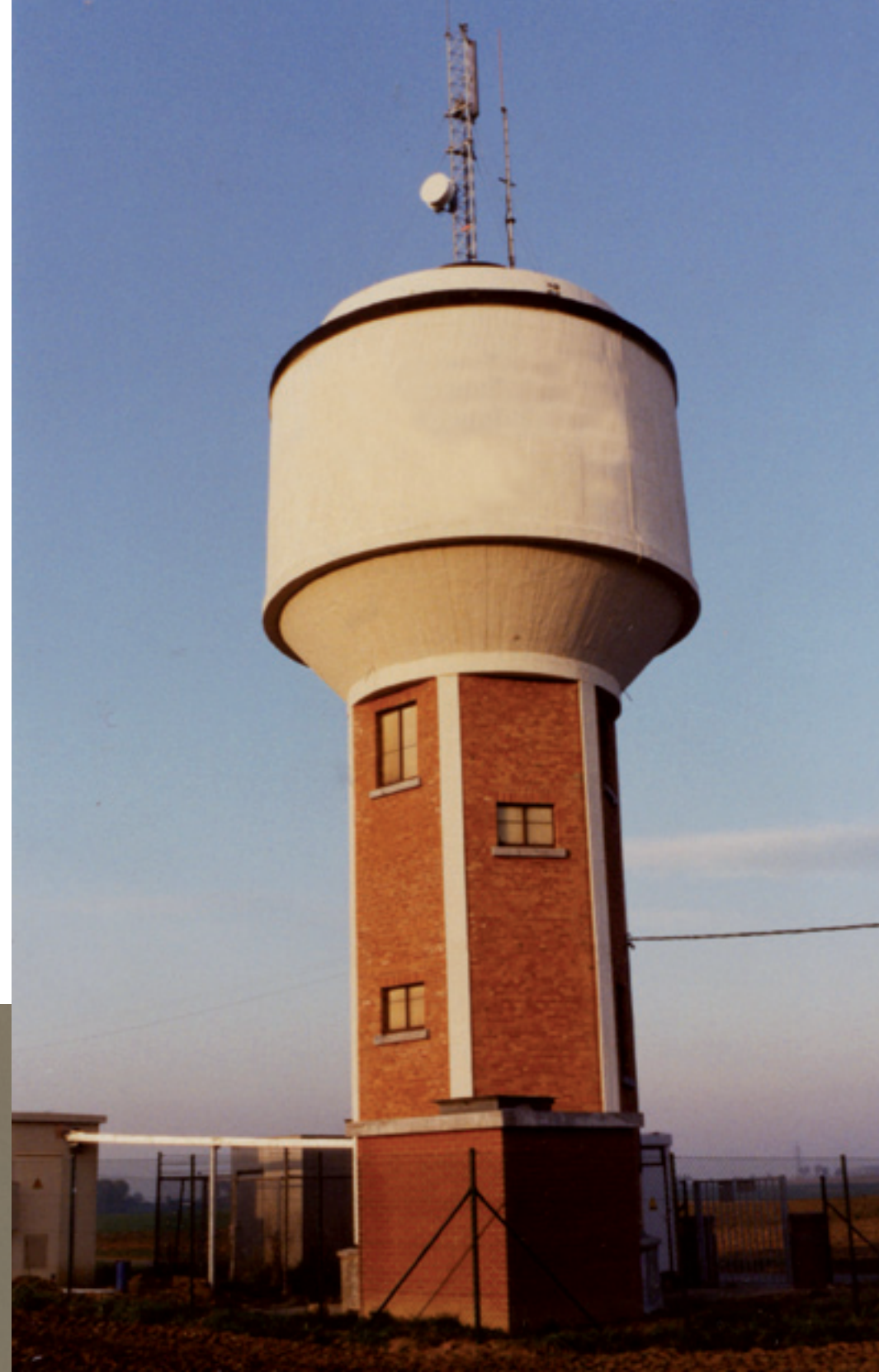
Château d'eau de Corbais
