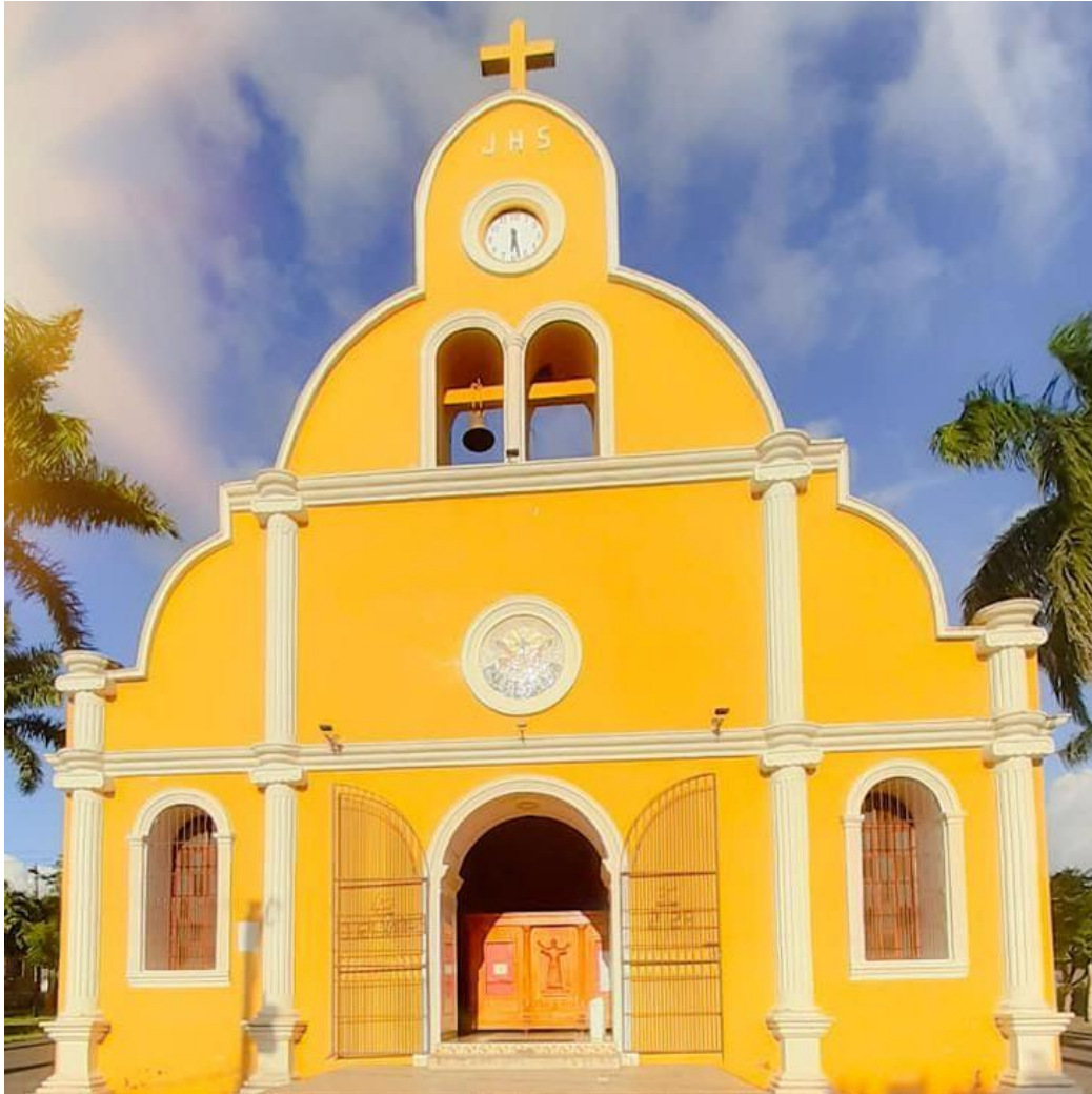
Fachada Iglesia San Francisco de Asís. Fuente: Construye no destruyas
