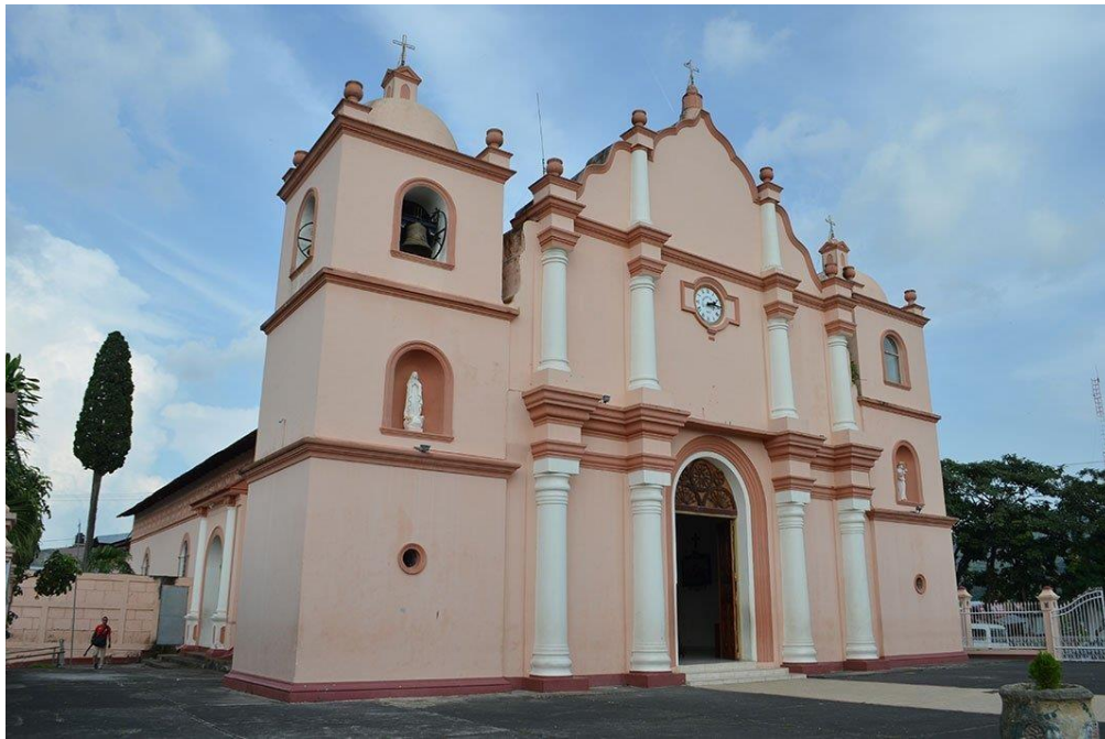
Fachada Iglesia Parroquial Santiago Apóstol.
