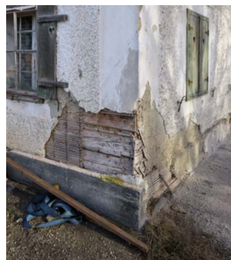
Abb. 89 (o.): Henkerhaus in Salzburg-Gneis, Neukommgasse 26. Auf der Wiese neben dem Haus fanden über 200 Jahre lang alle Hinrichtungen Salzburgs statt; Abb. 90 (re.): Hinter dem abbröckelnden Verputz wird die Holzkonstruktion des Gebäudes sichtbar.
