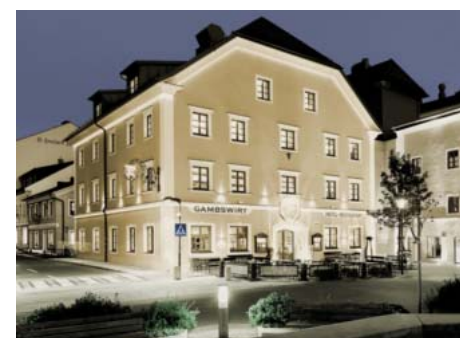
Abb. 100: Tamsweg, Sbg.: Gambswirt (Neubau nach dem Abriss)
