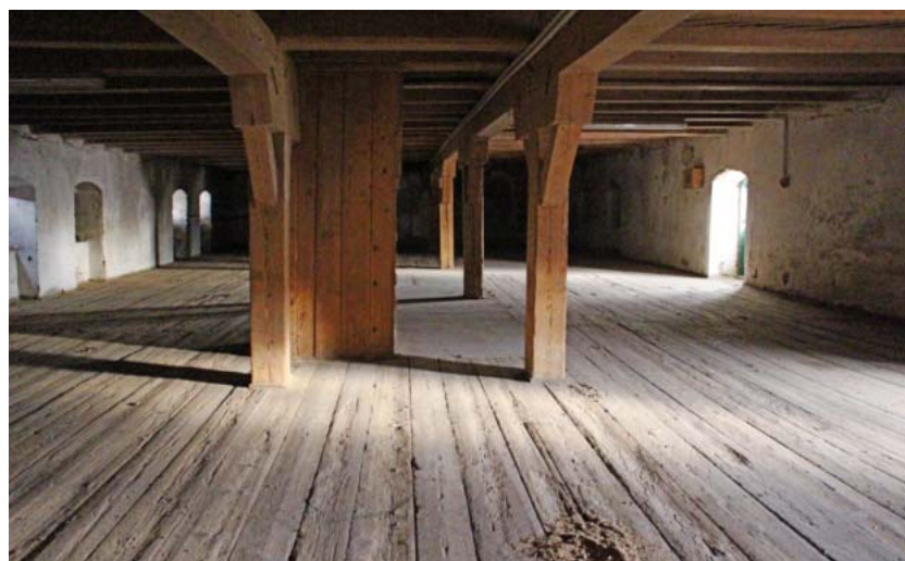
Abb. 55: Im Inneren des Speichergebäudes von Abb. 57. Dicke Mauern und Fenster ermöglichen optimale Temperatur und Trockenheit zum Lagern landwirtschaftlicher Güter. Abb 56 (re.): Der im Gebäude (in Abb. 58, rechts) befindliche Hebelarm der Brückenwaage scheint noch funktionsfähig zu sein und reagiert darauf, wenn außen die Stellfläche belastet wird. Bis 2015 war der Bauernhof noch in Betrieb, dann kaufte ihn der Wohnfonds Wien, um das Areal mittelfristig mit Großwohnsiedlungen zu bebauen.
