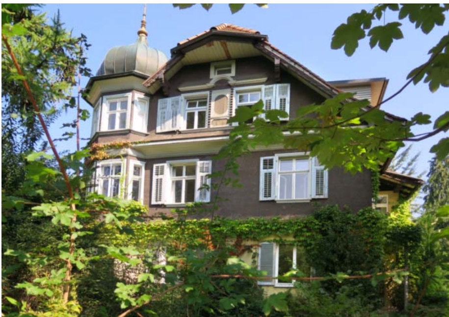
Abb. 91: Die akut vom Abbruch bedrohte Villa Freudeck im Georg-Baumeister-Viertel am Ölrain, Bregenz
