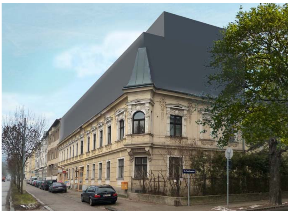
Abb. 29 (o.): Blick auf die der Hietzinger Hauptstraße zugewandten Fassaden der beiden Häuser; Abb. 30 (u.): Aufgrund von zahlreichen Protesten gegen den geplanten Totalabbruch reichte der Eigentümer im Frühjahr 2011 ein verändertes Projekt ein, das eine Teilentkernung und eine massive Aufstockung vorgesehen hätte. Hier eine grobe Skizze, die der damaligen Architekten-Visualisierung nachempfunden wurde.
