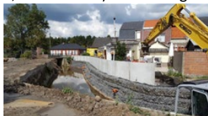
Foto 3: waterkering (bron: VMM)
