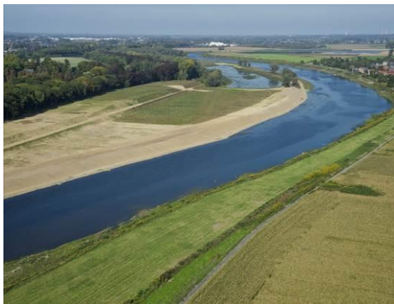
Foto 1: werken aan rivierbed Gemeenschappelijke Maas: links boven: verwijdering zomerdijk Bichterweerd, nieuwe zomeroever ; rechts boven: winterbedverlaging Hochter Bampd-zuid; links: nieuw verlaagd winterbed Hochter Bampd-zuid met hoogwatervluchtplaats; (Bron: nv De Scheepvaart)
