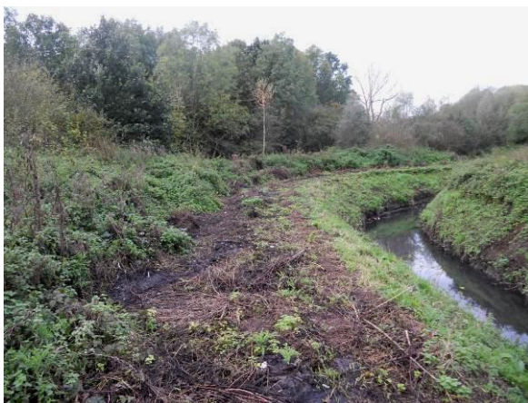
Foto 7: Kikbeek afwaarts het kanaal, de rechteroever zal worden afgegraven
