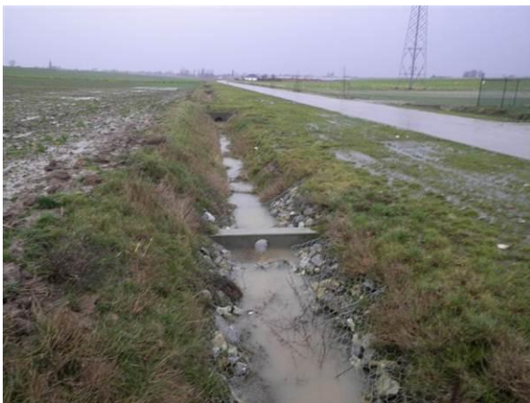
Foto 2a en 2b (boven): Millenbeek met bufferbekken langs de waterloop; Foto 2c: Millenbeek met aangelegde knijpconstructies in de waterloop
