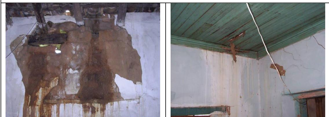
*Interior da antiga Prefeitura: detalhe nas paredes desgastadas e fiação solta*
