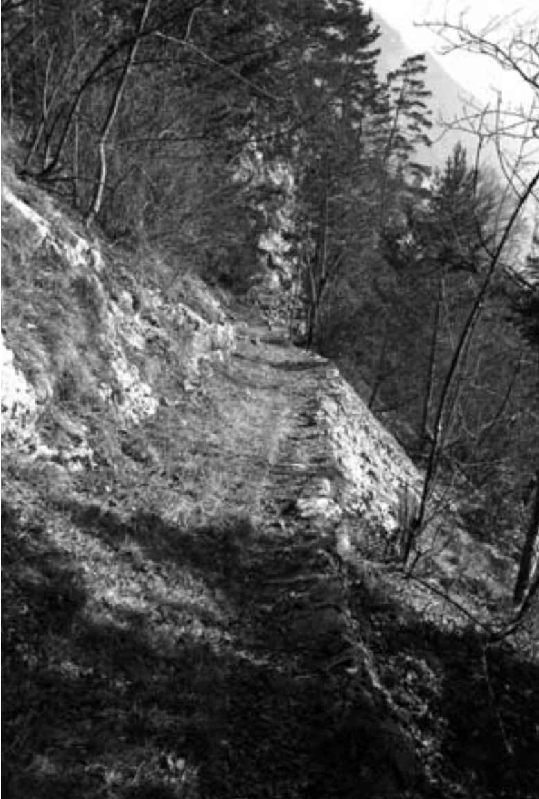
Der Militärweg am Lopper weist teilweise hohe schräge Böschungsmauern auf. Bergseits ist er in den felsigen Hang geschlagen.
