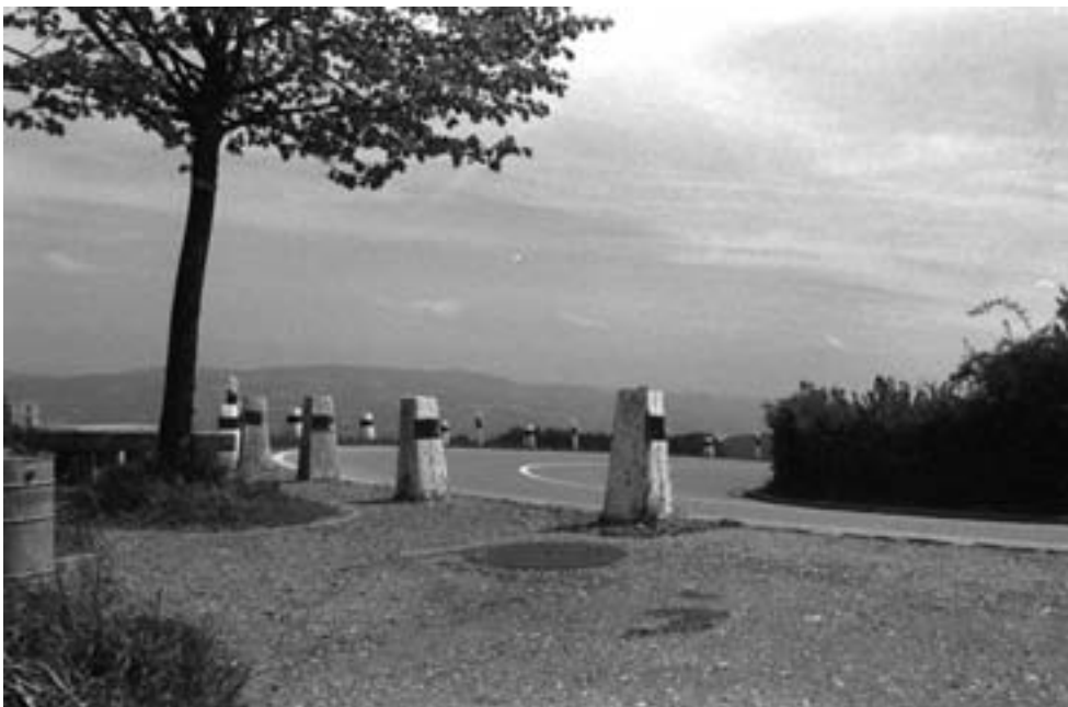
Abb. 43: Die halbrund behauenen Geländersteine bei Mittel-Albis erinnern noch an die Kunststrasse des 19. Jahrhunderts (ZH 8.4.1; Hans-Ulrich Schiedt).
