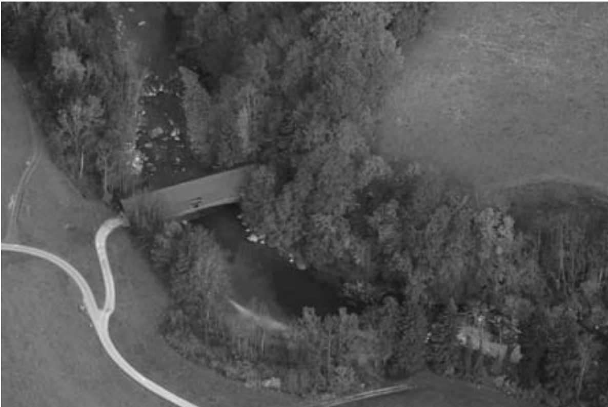
Abb. (unten): Ab 1850 führte die Strasse Horgen–Zug in Sihlbrugg über diese Brücke. Sie steht heute ca. 2 km weiter sihlaufwärts (ZH 3.5; Simon Vogt KA Zürich).
