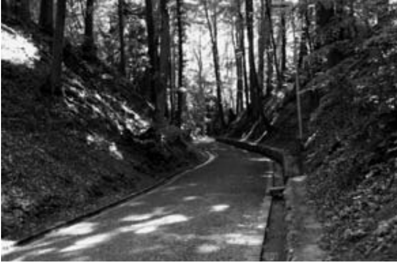
Abb. 28: Ein prächtiger Hohlweg mitten in der Stadt: die Winterthurer Turmhaldenstrasse. Am Fuss der linken Böschung sind noch einige trocken gemauerte Stützmauerreste erhalten (Markus Stromer).
