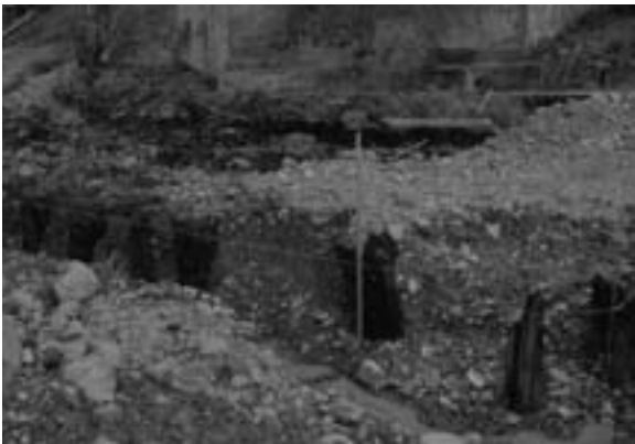
Abb. 47 (oben links): An trockeneren Stellen bestand der Strassenunterbau aus einer Geröllschicht (Ruedi Holenstein KA Zürich).
