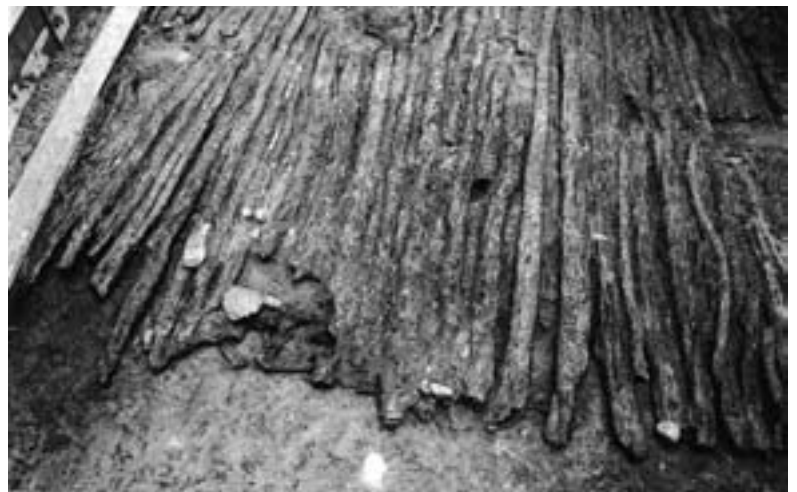
Abb. 46: Mit diesem Prügelrost befestigte man die römische Strasse in Otelfingen im feuchten Untergrund (Fridolin Mächler KA Zürich).
