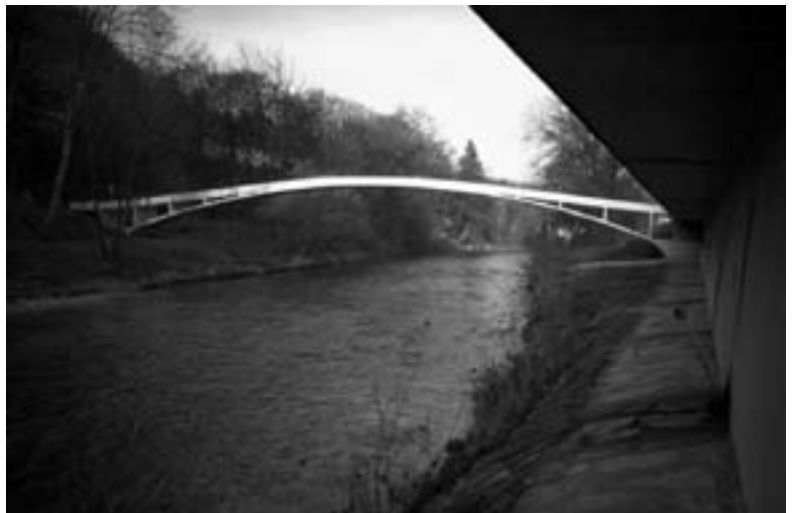
Abb. 34: Die besonders leichte Betonkonstruktion des Wülflinger Tössstegs fügt sich bestens in die Landschaft ein (Cornel Doswald).
