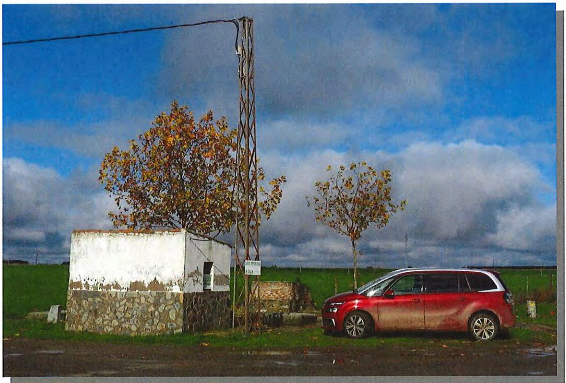
Fotografía nº 4. Caseta de protección del sondeo Tres Palos. Vista sur.
