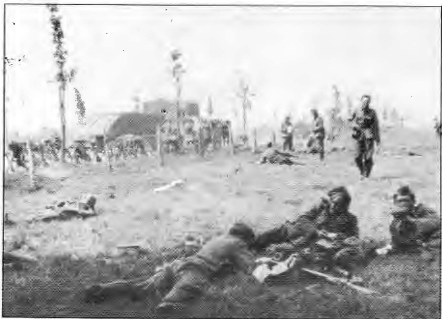
Even uitrusten ; op de achtergrond staan pontons klaar om verder een brug te bouwen.
