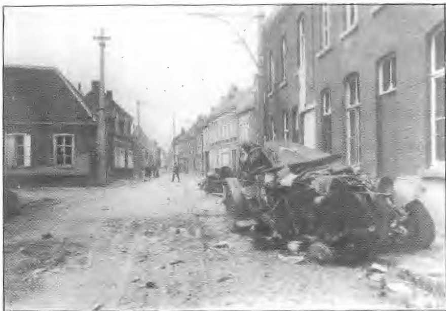
Op de Hul te Nevele hadden de Belgen mijnen geplaatst. Twee Duitse verkenningswagens werden hierdoor vernield.
