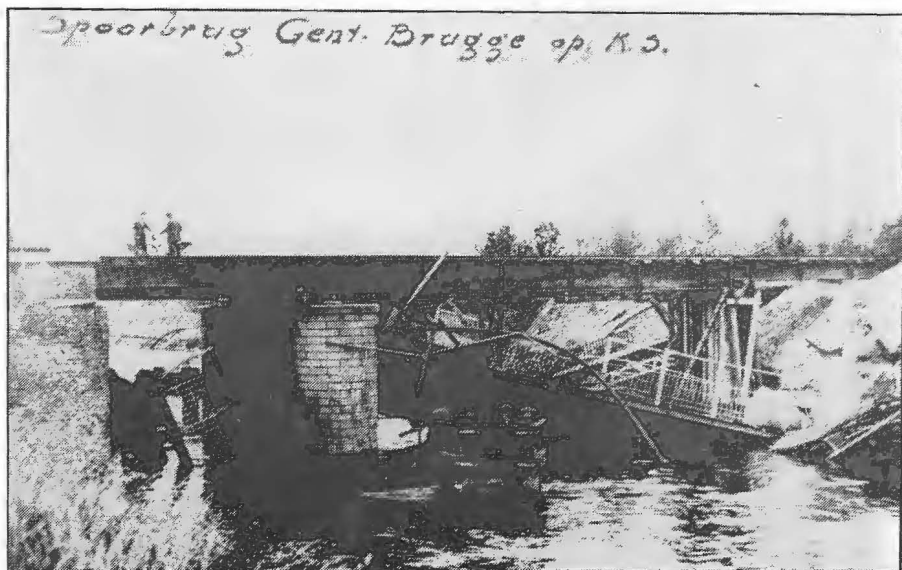
De spoorwegbrug te Landegem. Een noodbrug was reeds gelegd voor het treinverkeer.
