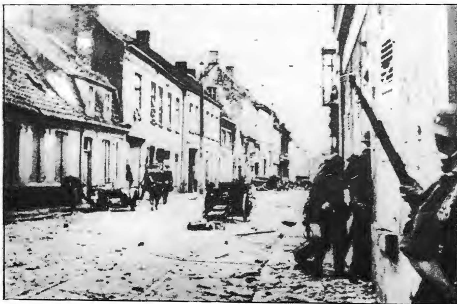
De Langemunt te Nevele met Duitse soldaten, een achtergelaten kanon en achteraan de Belgische versperring met wagens en karren. Links bemerkt men de gebouwen van de firma Naessens, de woning van Mestdagh en herberg „In de bombardon”, rechts het huis van Louis Van Maldeghem.
