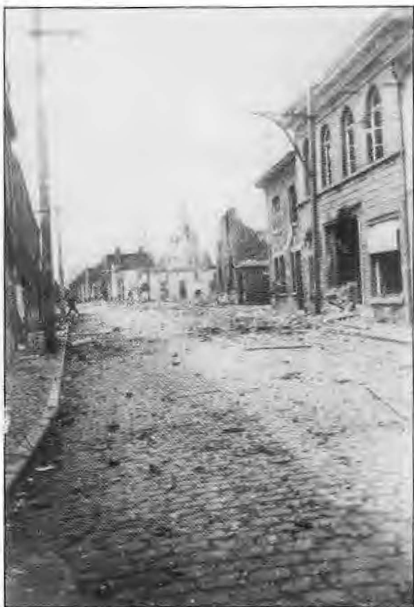
Aan de brug te Nevele, kant Langemunt, uitgebrande en vernielde huizen. Vooraan het huis van wed. De Pauw en het huis van De Jaeger nu eigendom van veearts Boone.
