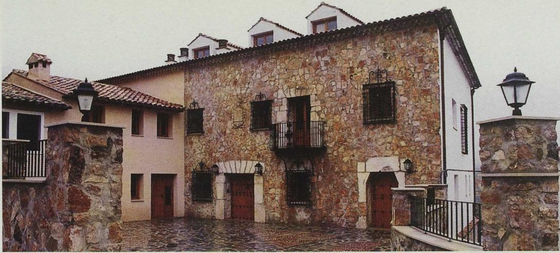
En las rehabilitaciones subvencionadas, las viviendas privadas deben cumplir los requisitos marcados por el Grupo. Checa.
