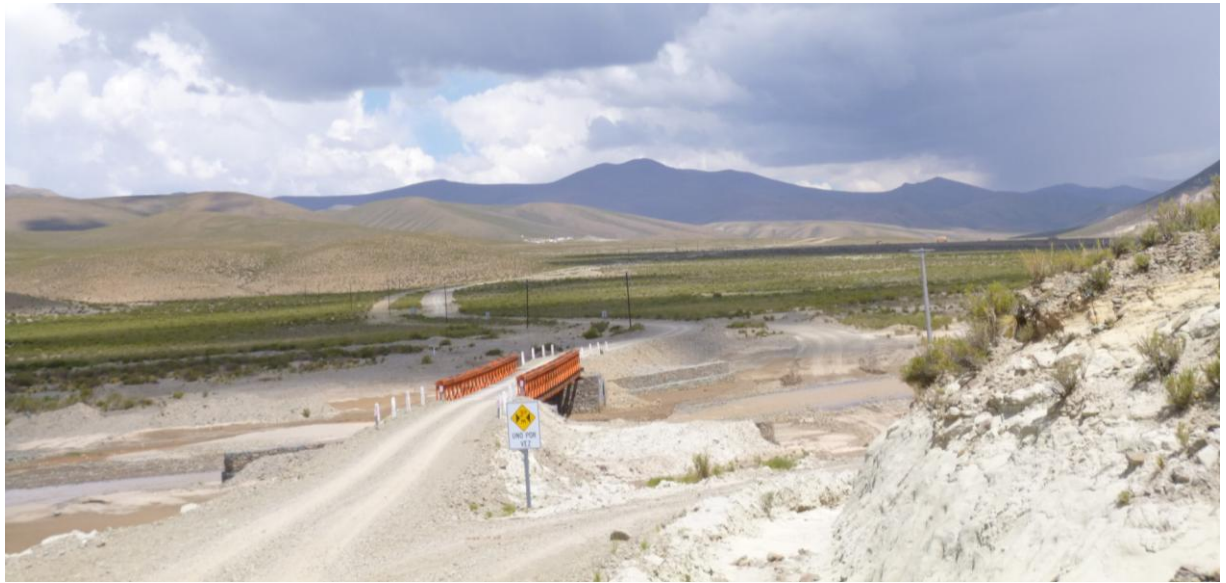
Imagen 38. Puente en RP 40 camino a Livivara. Fuente: Elaboración Propia
