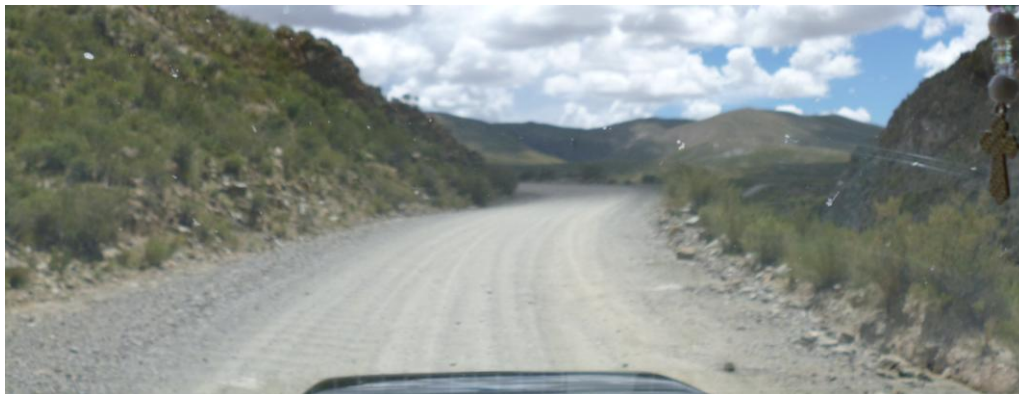
Imagen 29. Estado de la RP7. Camino a Rinconada. Muy buenas condiciones. Fuente: Elaboración Propia
