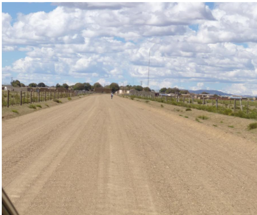
Imagen 31. Estado de la RP87. Camino a Cieneguillas.
