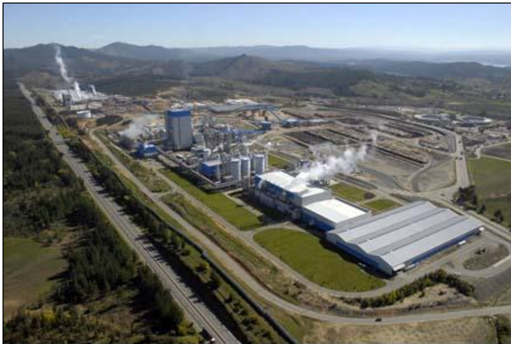
Figura N° 4.6: Fotografía CFI – Nueva Aldea, Arauco S.A. Fuente: Página Web www.arauco.cl .
