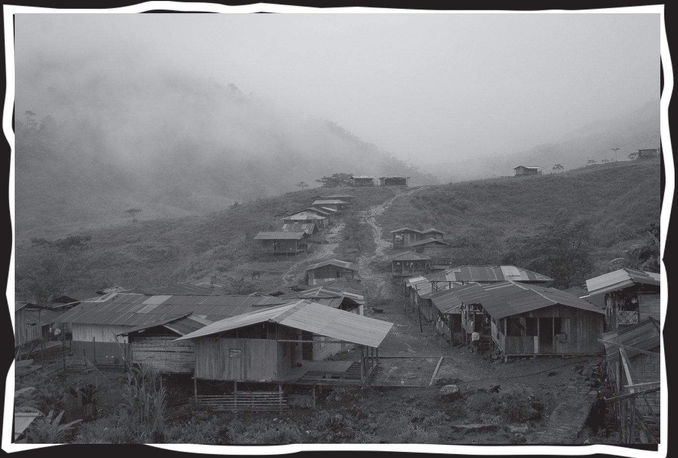
Vacíos y desafíos en la construcción de ciudad. Vista a viviendas de la comunidad indígena Aguasal. Comunidad indígena de Aguasal, Bagadó (Chocó), abril de 2006.
