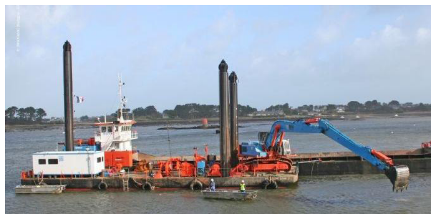
Figure 62 : Illustration d'un dragage mécanique d'une pelle sur ponton (source : VNF)
