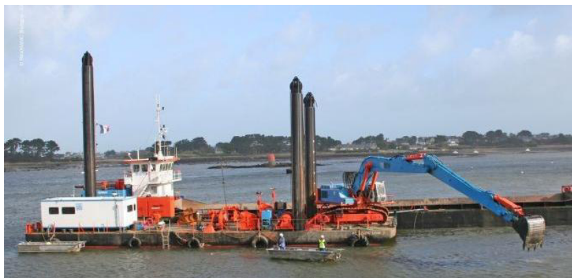
Figure 64 : Illustration d'un dragage mécanique d'une pelle sur ponton (source : VNF)
