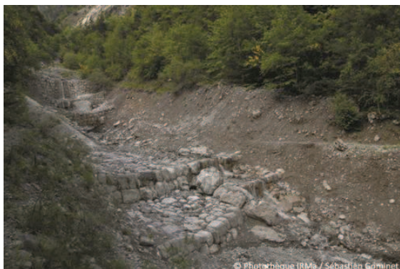
Barrages de correction torrentielle en pierres sur le Manival – © Photothèque IRMa / Sébastien Gominet (juin 2010)
