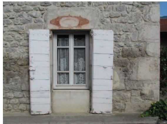
Ancienne enseigne de barbier sur le chemin du Village
