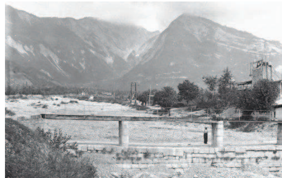
Passerelle piétonne et passage à gué sur le Manival, large d'une centaine de mètres, en 1891 – © RTM 38
