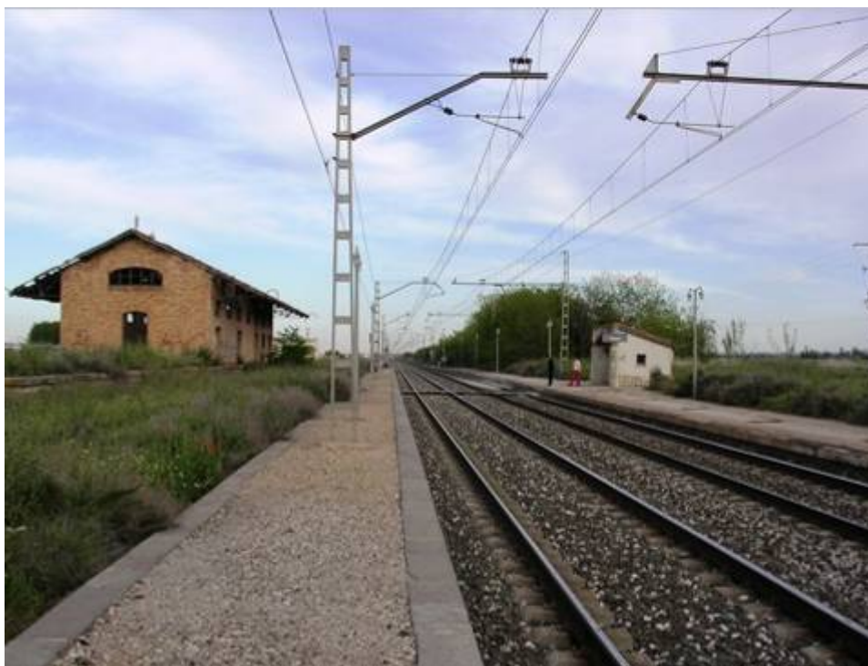
Estación de ferrocarril de Pedrola
