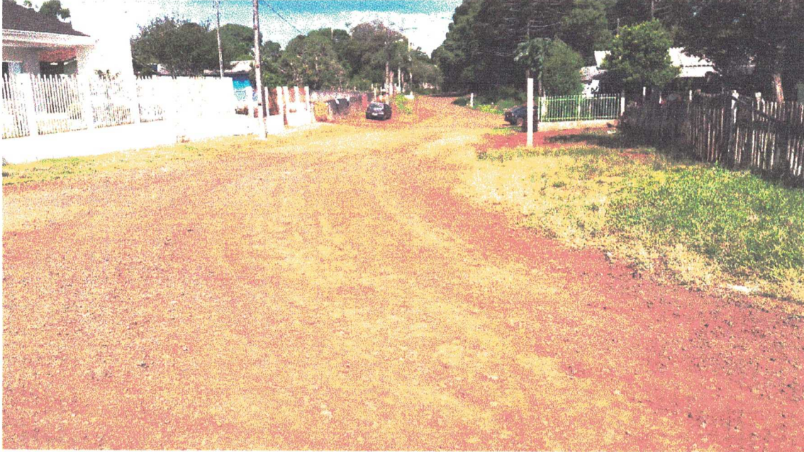
Vista do imóvel pela Rua Nova Tebas.
