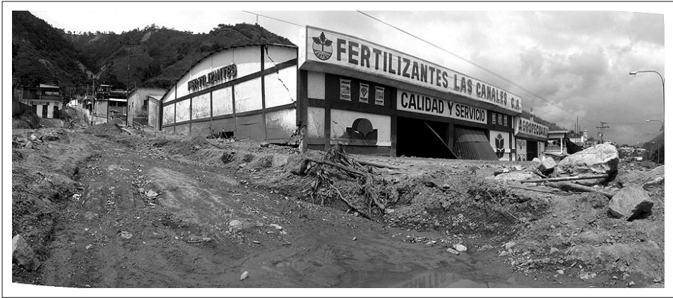
Figura 4. Uno de los flujos provenientes de la vertiente norte del valle. Se debe destacar la alta vulnerabilidad del sitio, al encontrarse un almacén con productos altamente tóxicos
