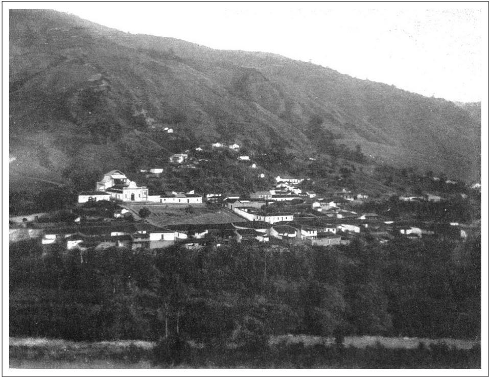
Figura 6. Aspecto que presentaba la ciudad de Santa Cruz de Mora para el año de 1920. Note el frondoso bosque que separaba la terraza donde se edificó el pueblo del cauce del río Mocotíes (foto cortesía del Ing. Pedro Rivero)
