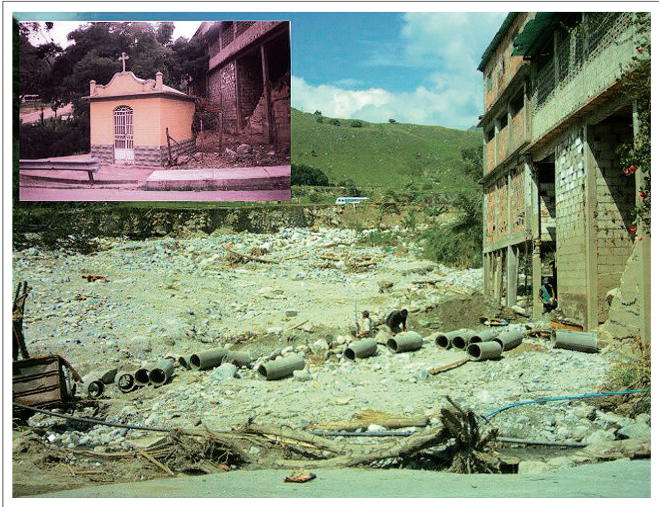
Figura 5. Grado de afectación experimentado por el sitio conocido como La Vega de Tacarica, el cual ha sufrido daños similares en diferentes eventos históricos. En el recuadro superior izquierdo se muestra una fotografía de la capilla de Tacarica, que se encontraba en ese lugar antes del evento de febrero del 2005
