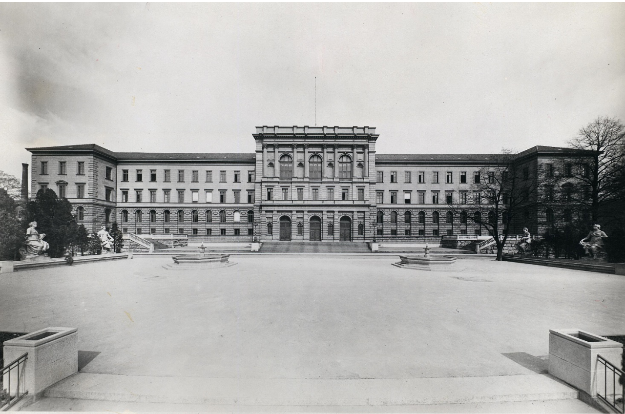
Unbekannt: Zürich, ETH Zürich, Hauptgebäude (HG), Fassade West mit Polyterrasse, ca. 1930 (Ans_00139, http://doi.org/10.3932/ethz-a-000012989 )
