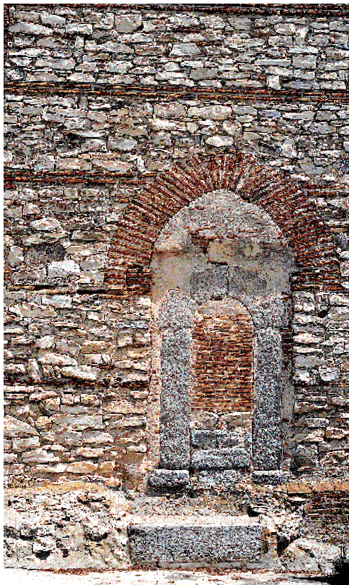
Puerta cegada de la torre
