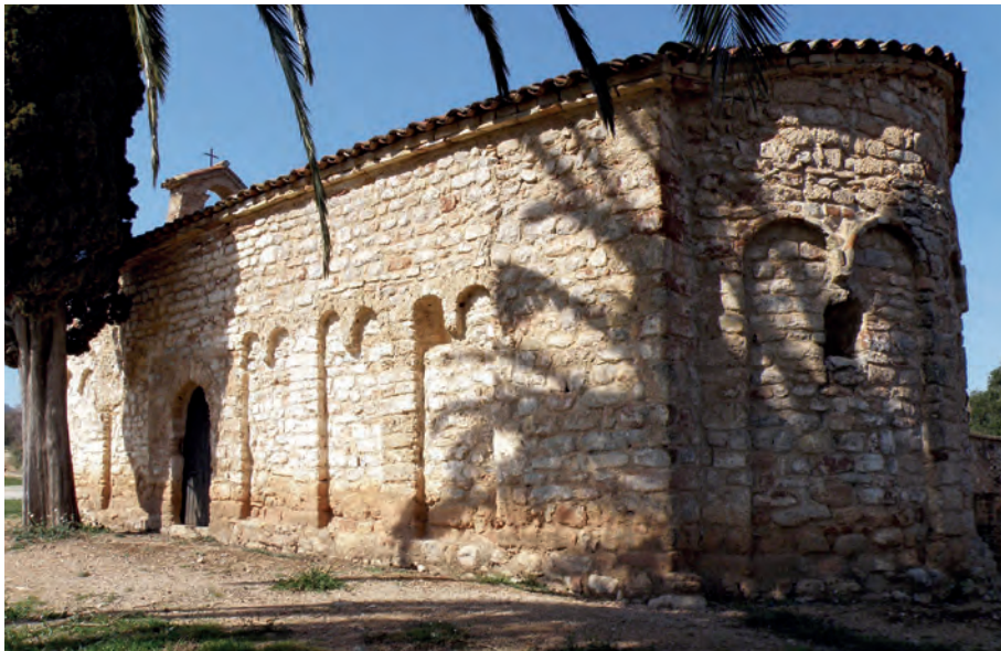
Vista general de la fachada meridional
