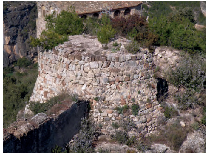
Detalle de la torre
