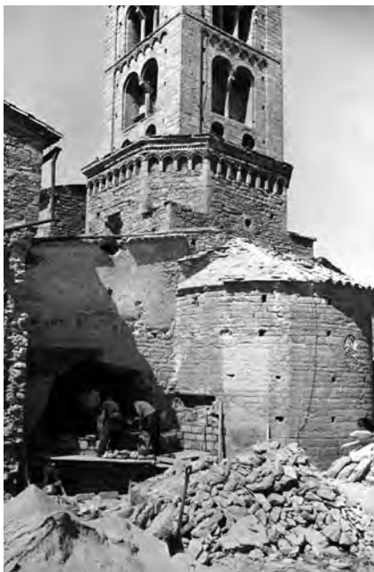
Iglesia de Santa Eugènia de Berga. 1956. ©Servei de Patrimoni Arquitectònic Local, Diputació de Barcelona
