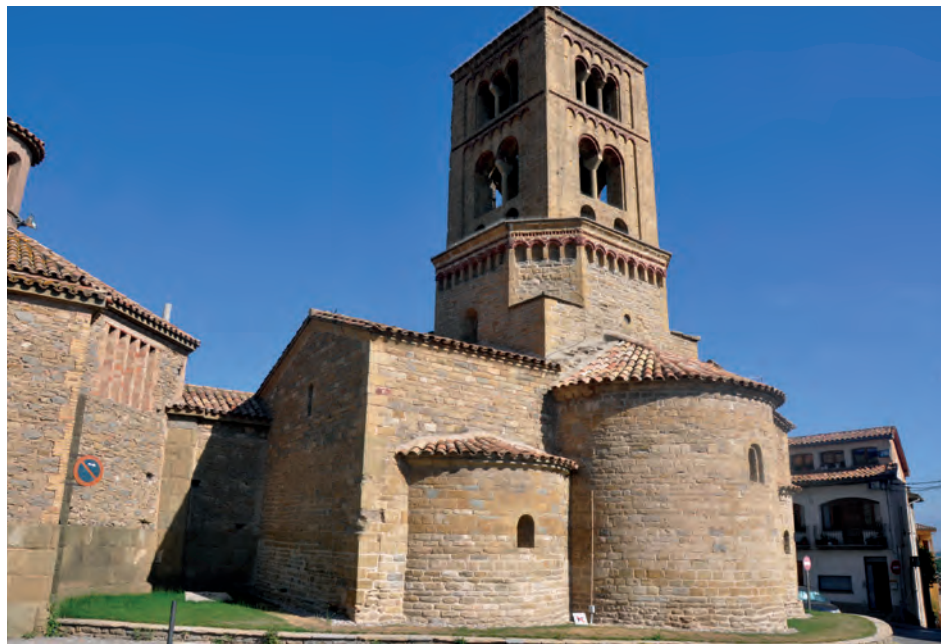
Vista general de la cabecera
