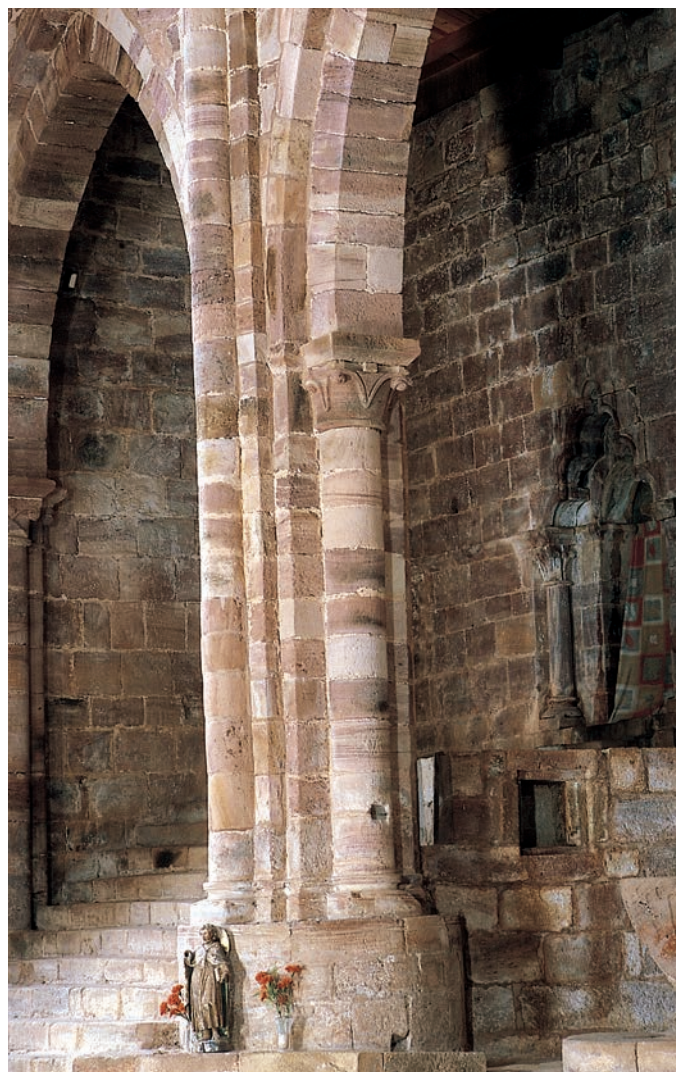
Pilar del primer tramo de la nave de la epístola y acceso a la torre
