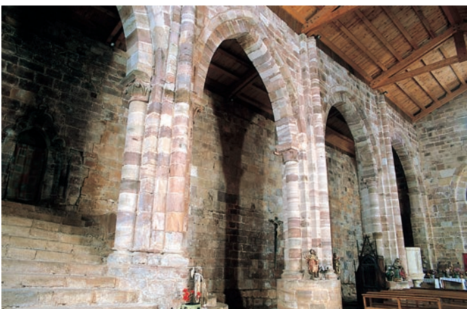
Pilares y arcos formeros
