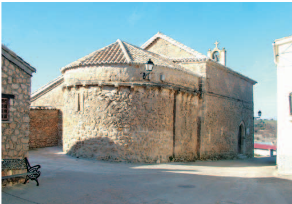
Vista exterior desde la cabecera
