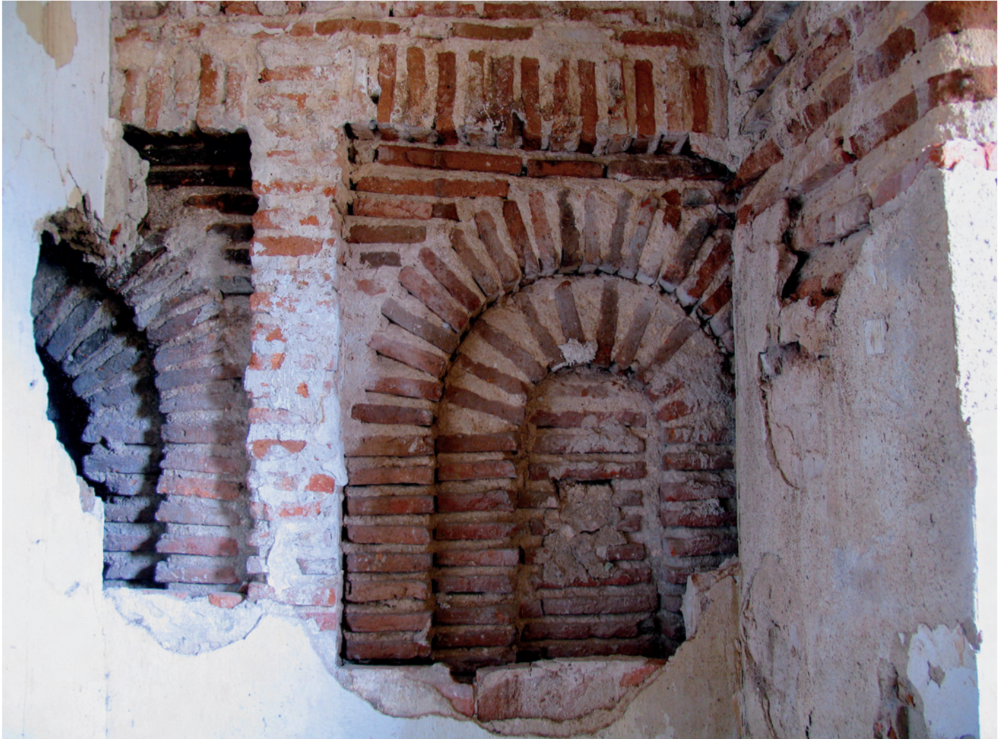
Detalle de las arquerías
