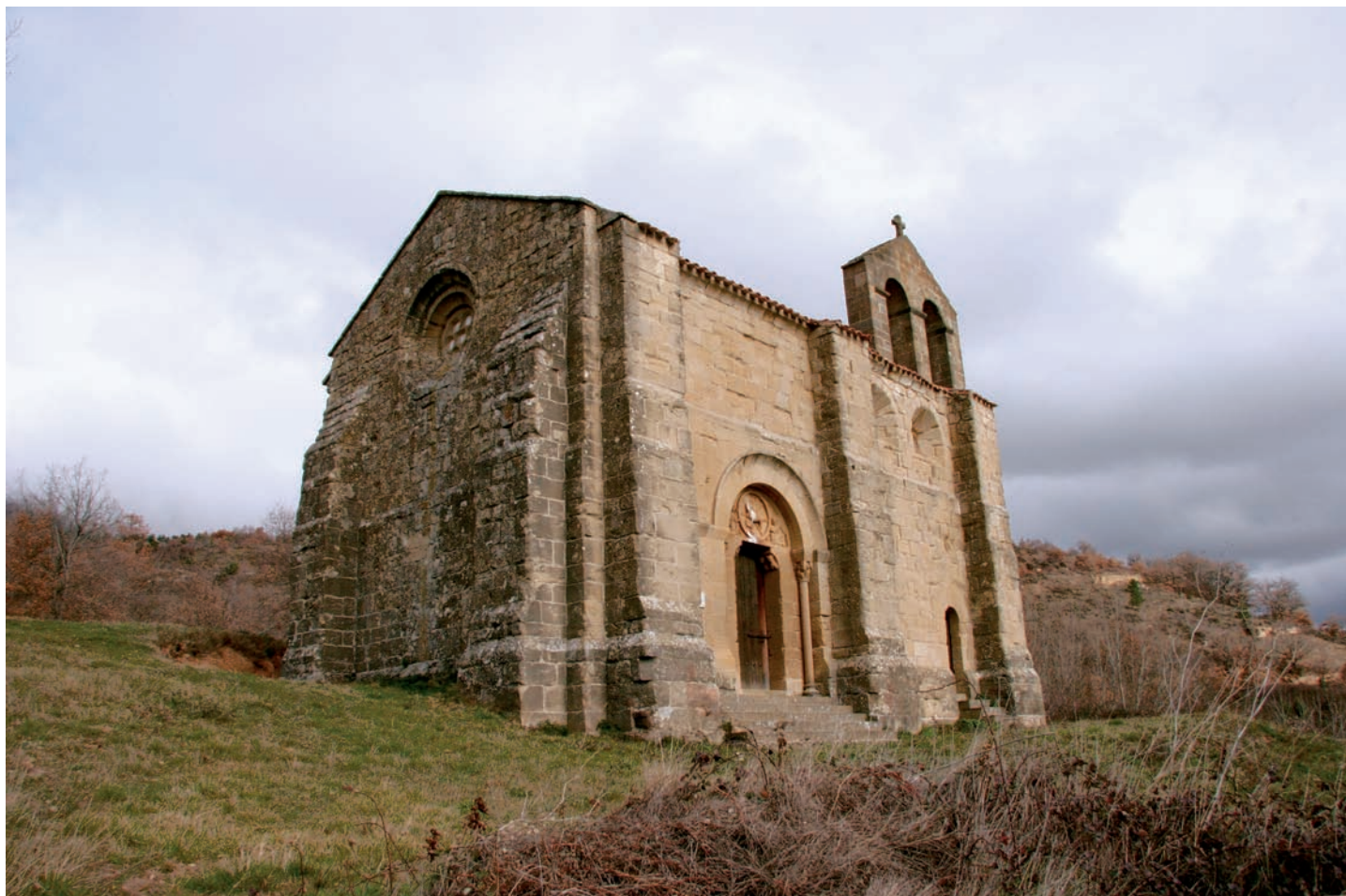
Exterior desde el Suroeste
