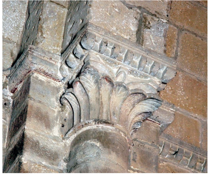
Capitel de la nave
