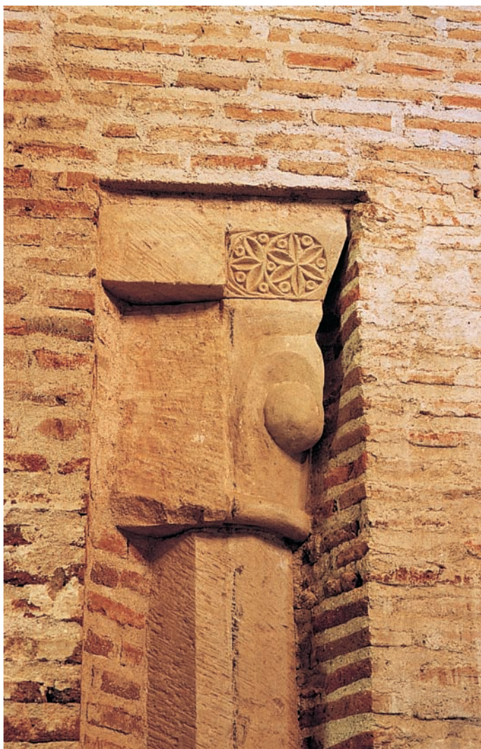
Capitel de la nave
