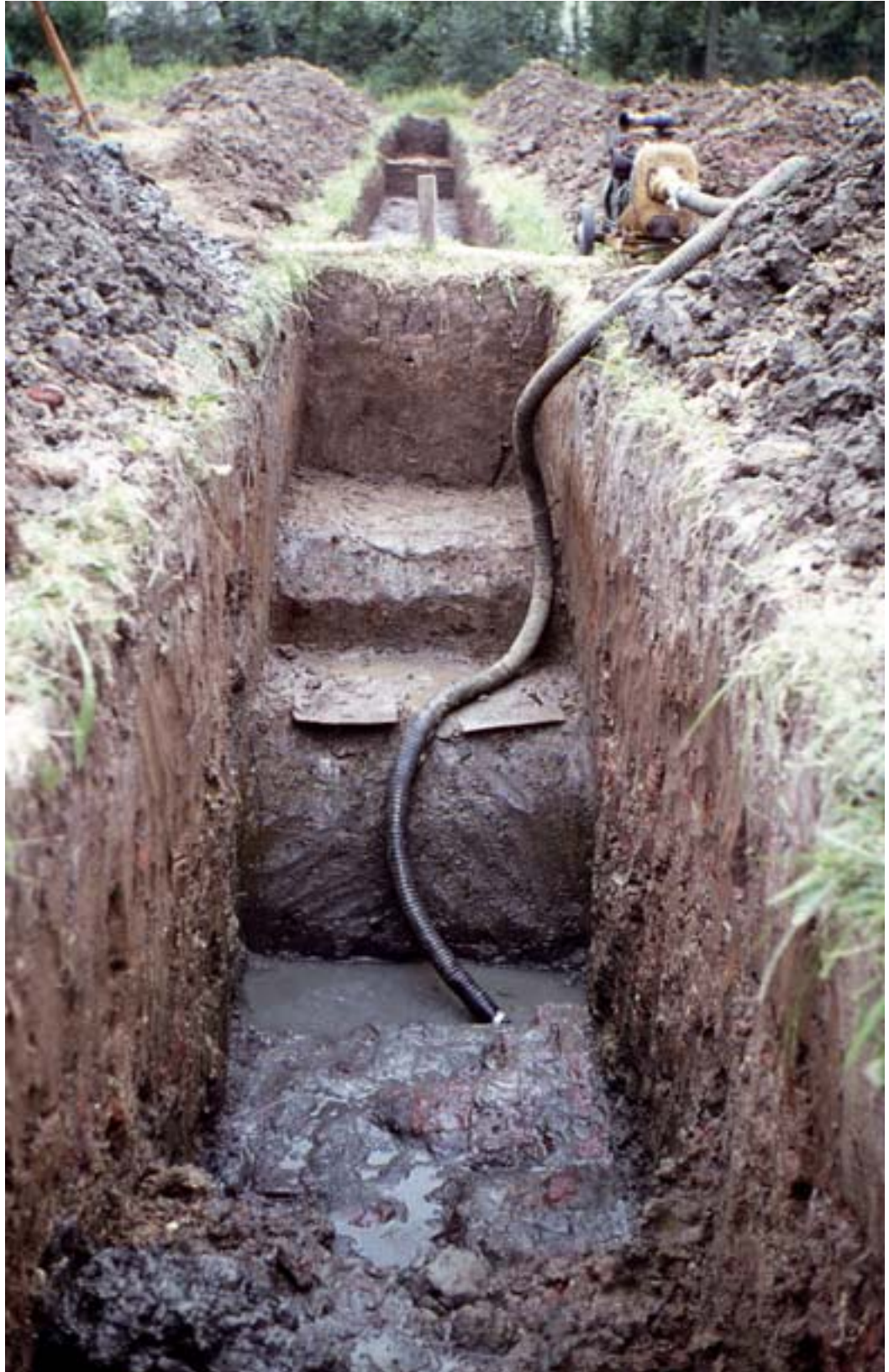
Figuur 11. De fundering in sleuf 2 gezien vanuit het zuidoosten met op de achtergrond de fundering in sleuf 1, 1971 (collectie M. Cock, Schendelbeke).
