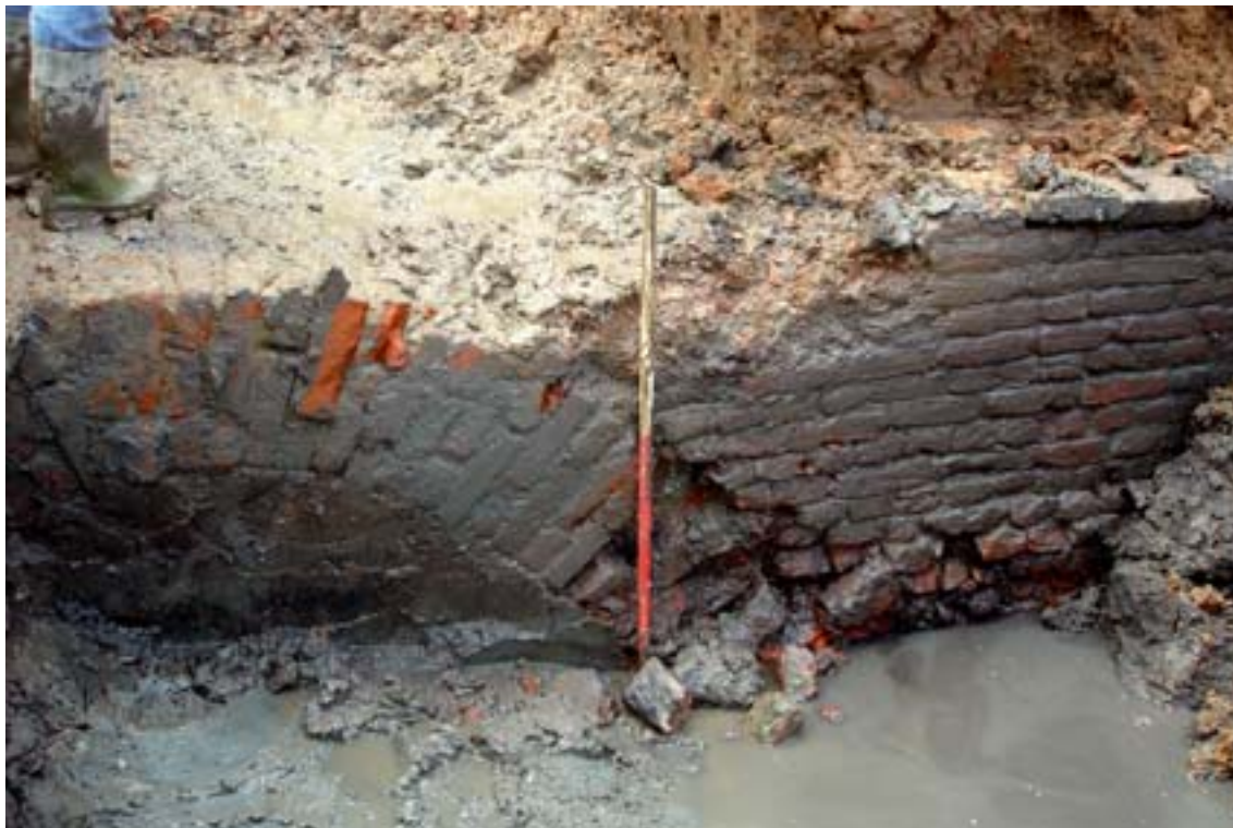
Figuur 37. Grondboog (spoor 14) met aansluitende weermuur (spoor 16) gezien vanuit het zuid-oosten.
