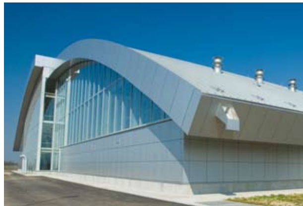
Station de potabilisation d'Ecaussinnes
