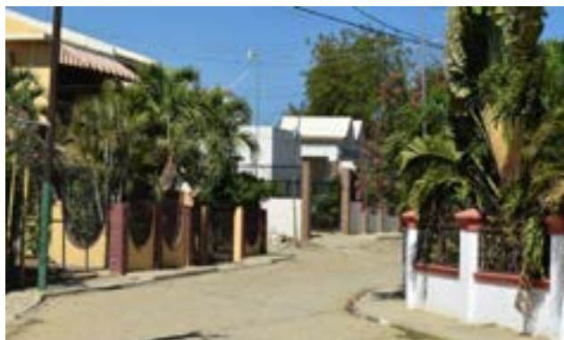
Viviendas de Las Matas de Santa Cruz
