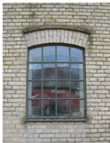
Magasinsbyggnaden vid Teckomatorpsgården bevaras.
