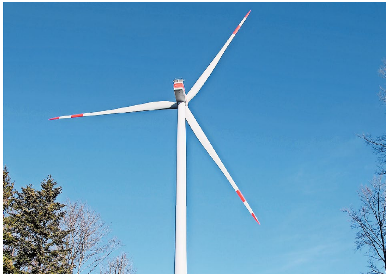
Die drei Windräder auf dem Verenafohren erreichen bei einer Nabenhöhe von 134 m eine Gesamthöhe von 199,5 m und es sind für den Windpark 76 ha Wald beansprucht worden.
