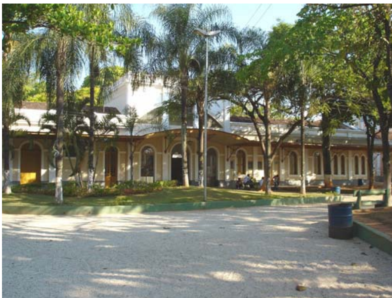
Foto 25 – Edifício Histórico na praça: a Estação
