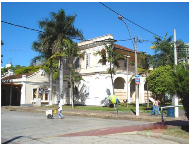
Foto 27 – Edifício Histórico na praça: Casa do Chefe.
