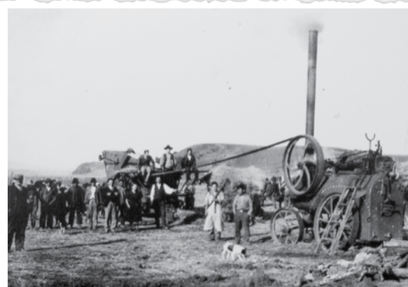
Trilla con motor locomóvil.
