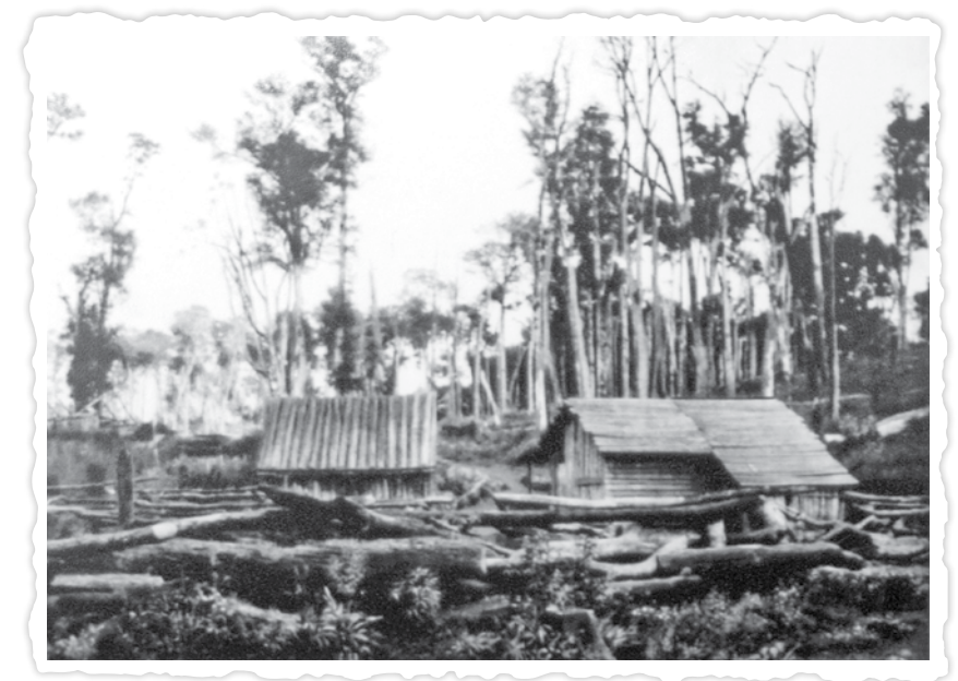
Casas de colonos auto construidas en La Araucanía.
