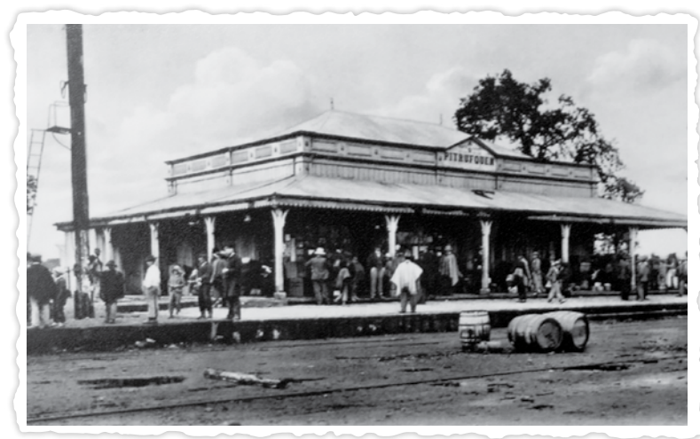
Estación de ferrocarriles de Pitrufoquén.
