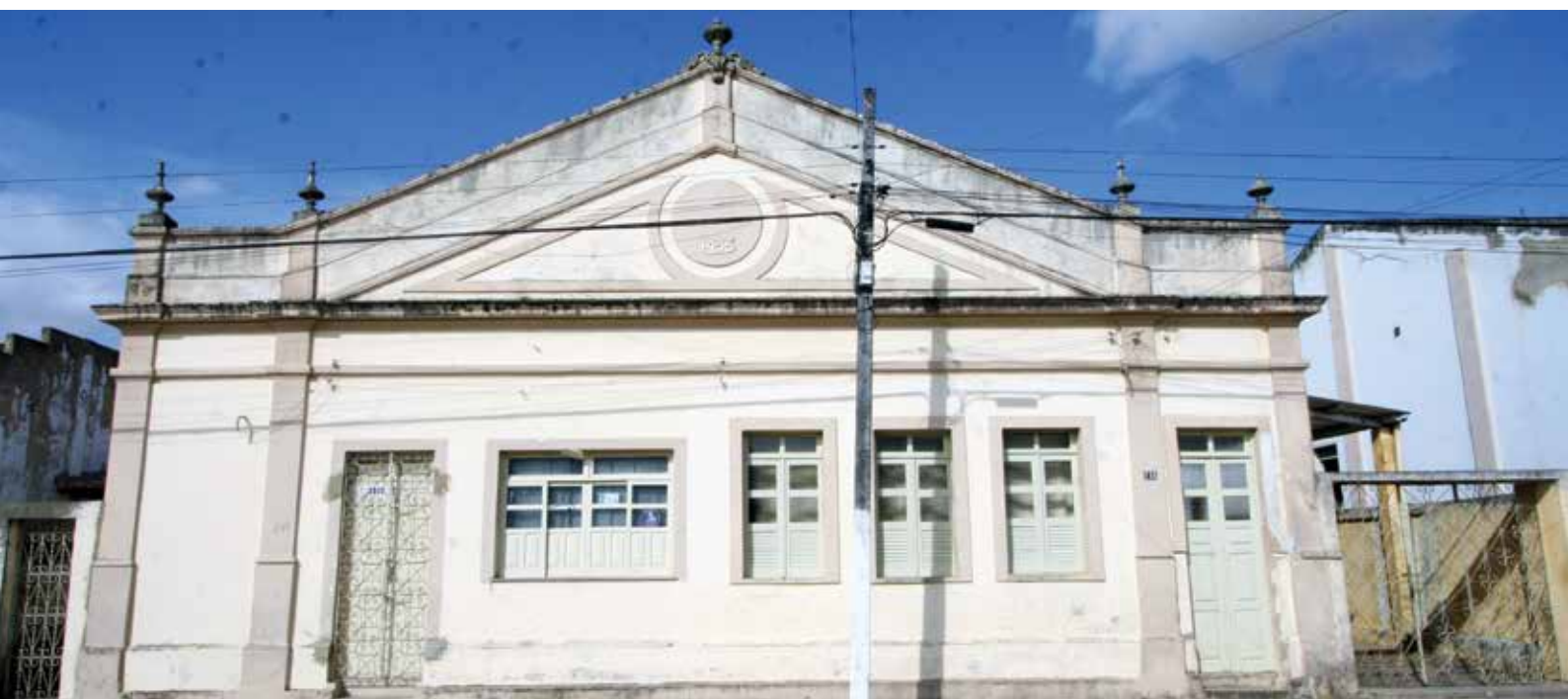
Fachada de uma antiga residência de Boquim
