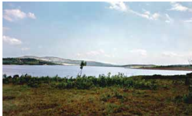
Barragem do Brito
