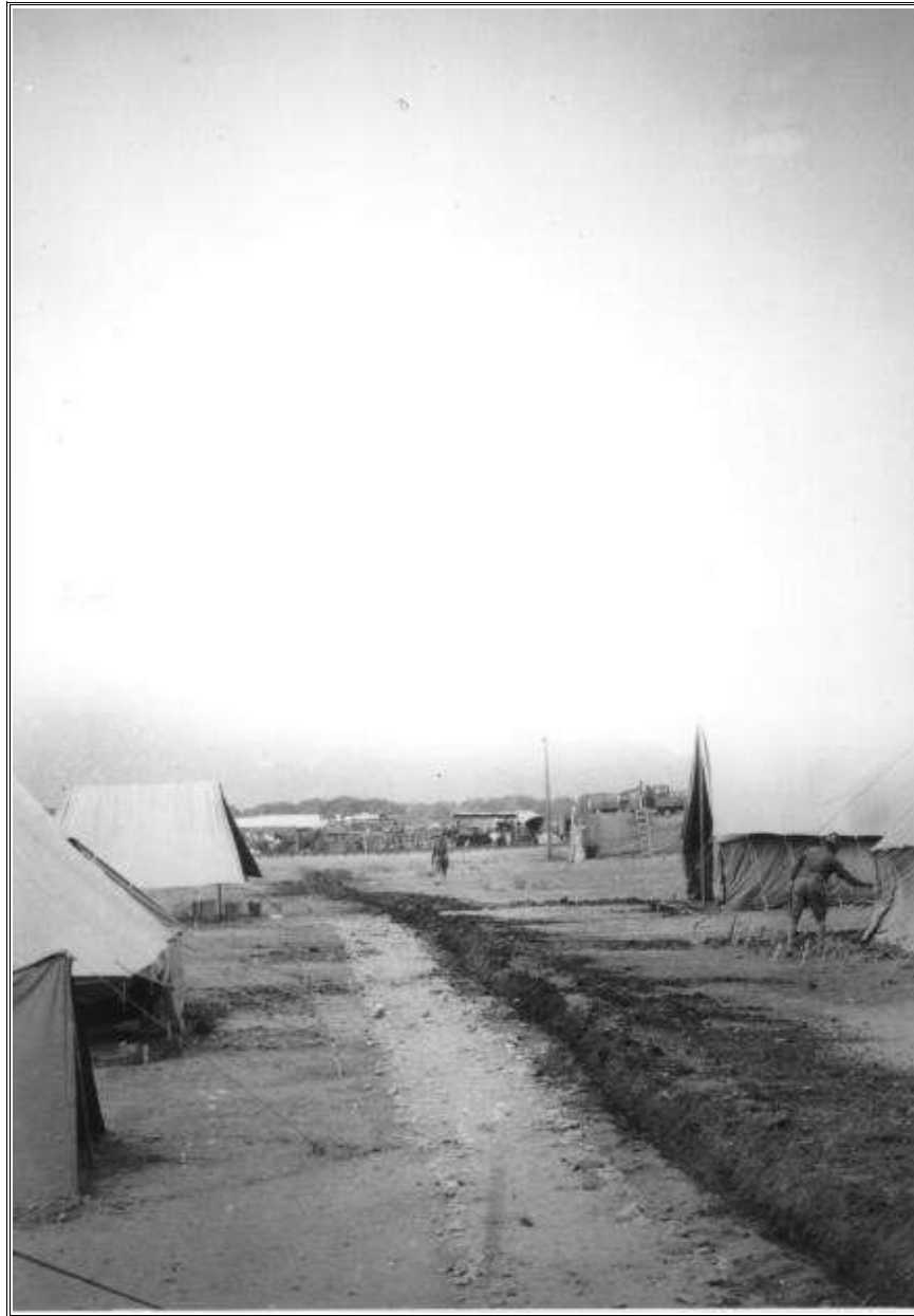
Foto 12. Canales de desague en un campamento para evitar inundaciones dentro de las casas de campaña durante la época de lluvias (Foto William Fox).
