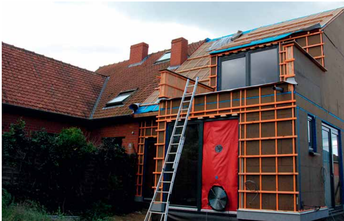
De BlowerDoor-luchtdichtheidstest visualiseert duidelijk de impact van luchtlekken. (© Isoproc-Innoviso)
