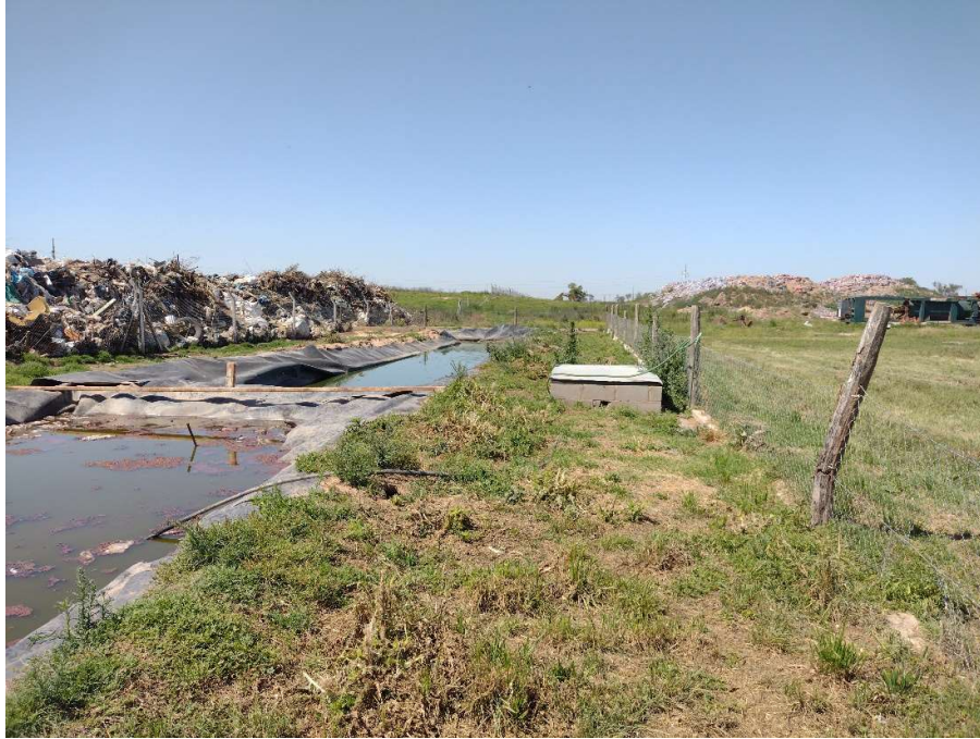
Foto 12. Piletas de recolección de lixiviados actual.
