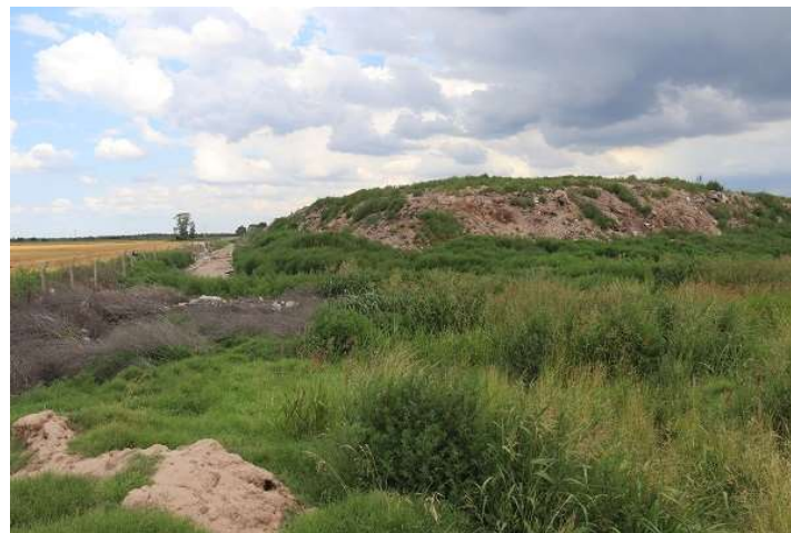
Foto 13. Vista general de la vegetación sobre el sector más antiguo del basural.
