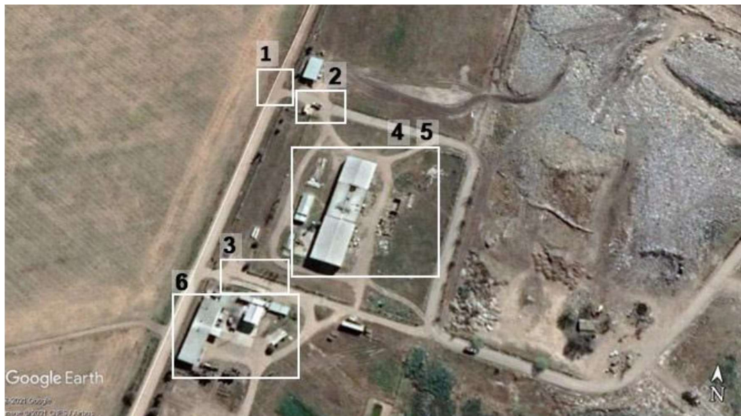
Imagen 4. Infraestructura existente actualmente en el predio.
