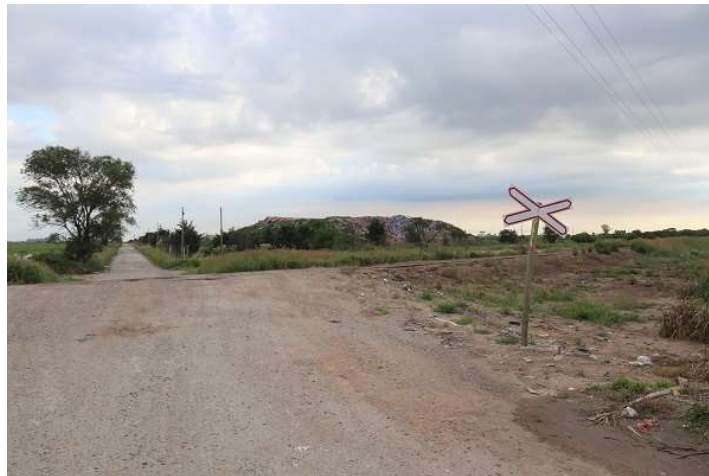
Foto 5. Vista del ingreso al predio desde la ruta Nº2. Se observan las vías del tren, el camino de acceso y la acumulación de residuos patogénicos tratados.
