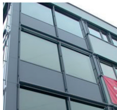
Objekt House of Sports, Uster Bauherr Lehner + Partner, Zug Architekt Meierpartner Arch., Wetzikon
