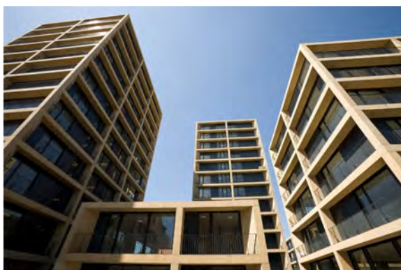
Abb: Überbauung Skyline (Nr. 23.3; Foto: www.skyline.ch, Abruf 2017)
