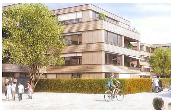
Abb: BGZ-Siedlung, im Bau (Nr. 8.124; Bild: Studienauftrag 2014, Siegerprojekt Althammer Hochueli)
