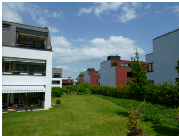
Abb: Quartierplangebiet Unterdorf, Wohnüberbauungen 19.59 und 19.77 (Foto Planpartner, 2010)
