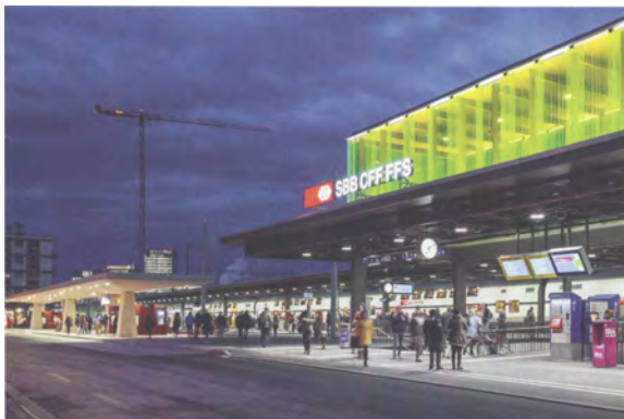
Abb. Nrn. 3.2.1 und 3.2.2: Ausbau Bahnhof Oerlikon, Kopfbau Nord / Max-Frisch-Platz, Eröffnung 2016 (Quelle: sia-Preis, 2017)
