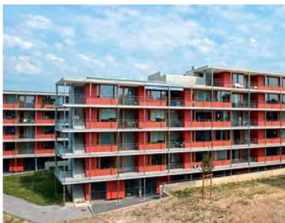
Abb: Studentenwohnsiedlung Bülachhof, 2. Etappe fertig 2004 (3.85.1 (Foto Alexander Gempeler)
