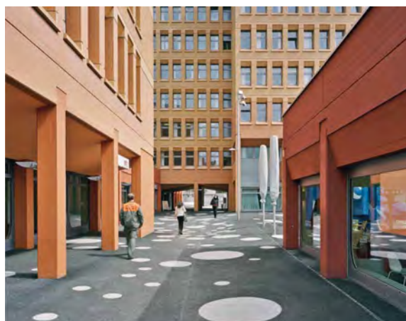
Abb: Zentrumsüberbauung Dorflinde, umfassende Sanierung, fertig 2011 (Nr. 3.134; aus Tec21, Dossier Dorflinde, Foto Georg Aerni)
