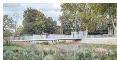
Voorbeeld van een kwalitatieve passerelle over een groengebied - Agence Ter, Saint-Ouen, Frankrijk
