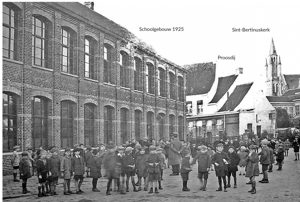
Het eerste schoolgebouw op de Vroonhofsite omstreeks 1925
