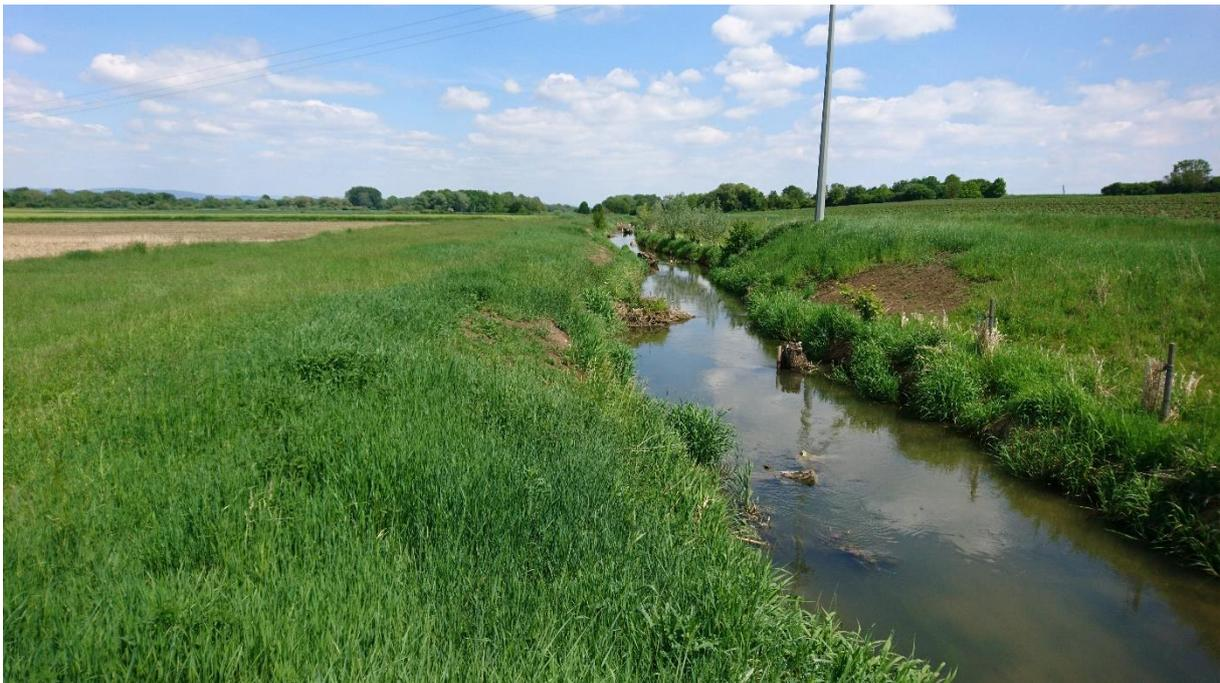
*Pfatter zwischen Sengkofen und Taimering: Typisch ist der begradigte Verlauf, fehlender Gehölzsaum und Strukturarmut im Gewässer. Hier wurden 2018 zur ökologischen Verbesserung Wurzelstöcke und Lenkbuhnen eingebracht, Ufer abgeflacht und Gehölze angesiedelt (Initialpflanzung)*
