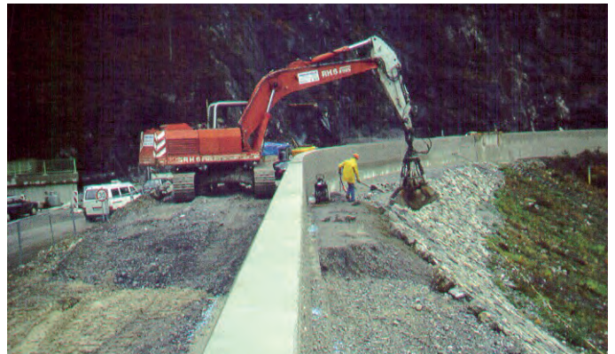
▲ Sicherung der verlängerten Dammböschung mit Steinsatz
