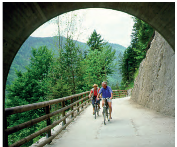
▲ Fertiger Radweg zur Dammkronen
