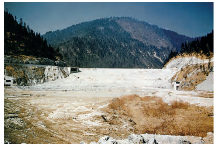
▲ Sylvensteindamm (Wasserseite) kurz vor dem Einstau. Links der Einlauf des Grundablassstollens, rechts der Triebwasserstollen und oben links die Hochwasserentlastung
