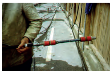
◀ Injektionslanze mit Doppelpacker
