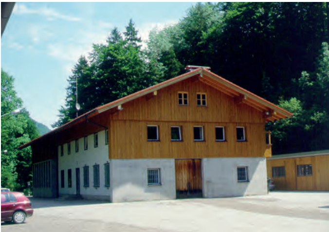
▲ Betriebsgebäude nach der Modernisierung
