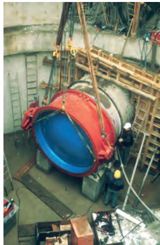
▲ Einbau der Drosselklappe zum Schnellschluss der Turbine
