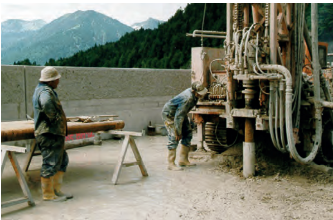
▲ Bohrungen für den Messsonden-Einbau
