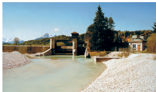
◀ Am Krüner Wehr werden seit 1924 bis zu 25 m³/s Isarwasser zum Walchensee abgeleitet (Blick von Unterwasser auf das Wehr)
