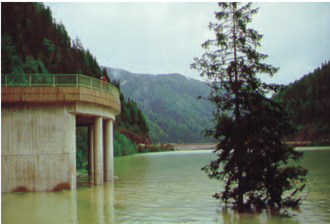
▲ Höchstler Seewasserstand mit 762,85 mNN. Bis zur Kronenmauer war noch genügend Sicherheit
