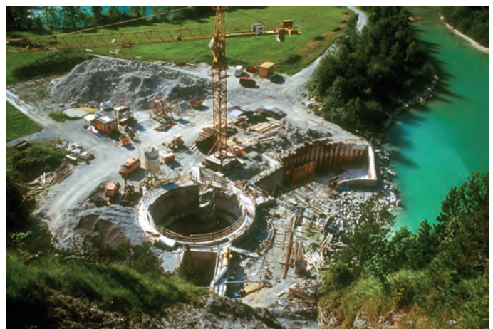
▼ Kraftwerksschacht mit Auslaufbereich während der Bauarbeiten
