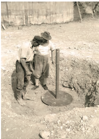
◀ Arbeiter beim Einbau von Setzungspegeln
