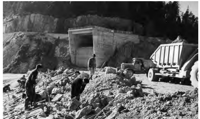
▶ Grundablass - Einlaufbauwerk mit verriegelter Revisionschütze
