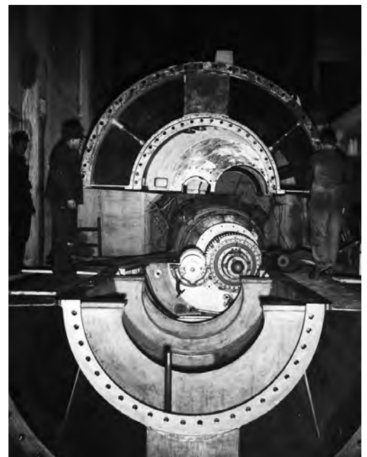
► Montage der Kaplan-Rohrturbine
