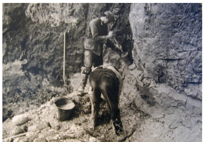
▲ In Handarbeit wurde der Anschluss Damm / Fels mit Ton abgedichtet
