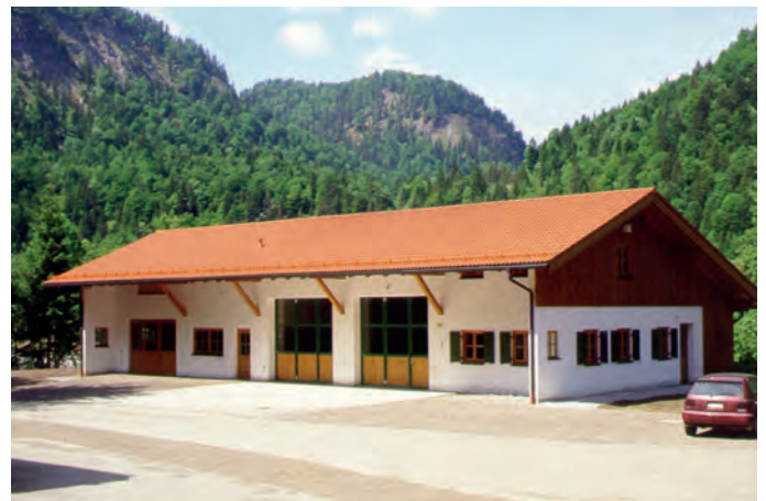
▲ Im neuen Nebengebäude sind Werkstätten, Magazine, Garagen und Sozialraum untergebracht
