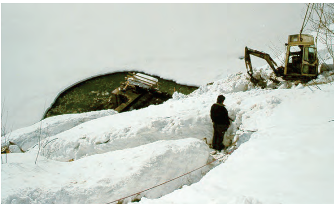
▲ Extreme Winterverhältnisse erschweren die Umbaumaßnahmen
