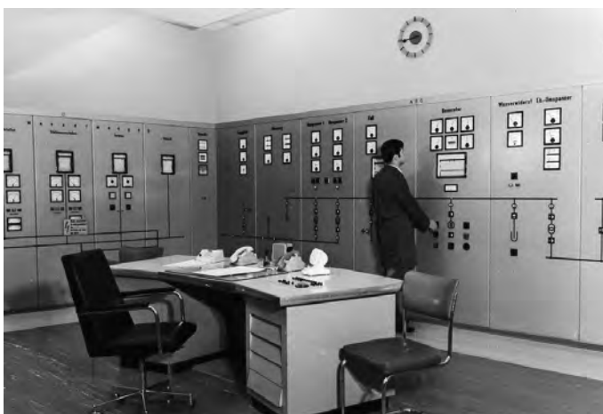
▼ Schaltwarte im Betriebsgebäude - von hier aus wird der Speicher- und Kraftwerksbetrieb gesteuert
