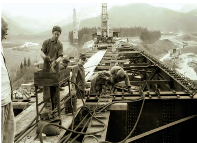
▲ Schlagen der Niete für die Faller-Klammbrücke
