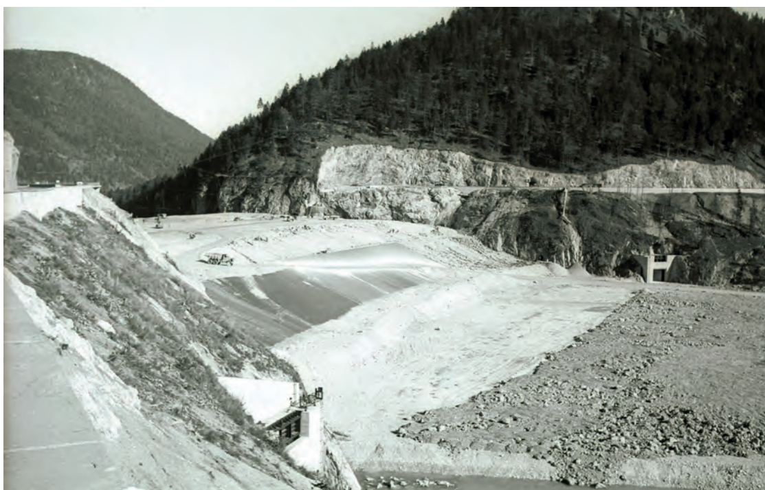
◀ Der später überstaute Dichtungsteppich aus Lehm wirkt als Bremsschicht und verlängert die Sickerwege im Untergrund ▶
