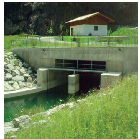
▶ Auslauf vom Kraftwerk zum Kolksee
