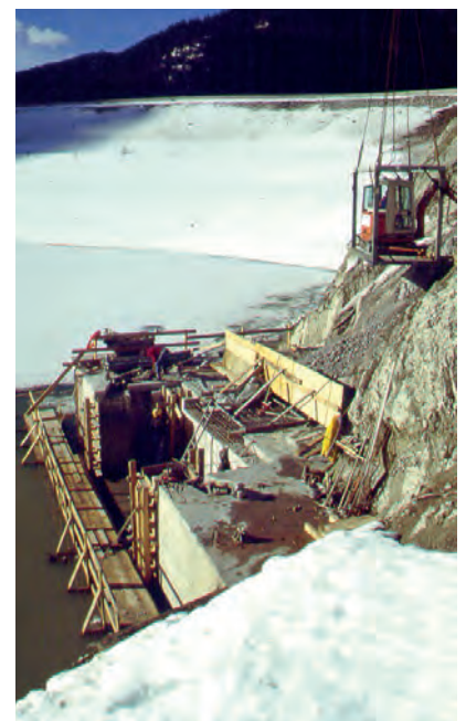
▶ Revisionsverschluss - Umbau am Einlaufbauwerk
