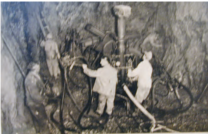
▲ Die Bohrlöcher für das Aussprengen der Stollen wurden mit Pressluft-Bohrgeräten hergestellt
