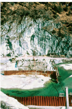
▲ In 3 Bauabschnitten wurde die Dichtungsschürze hergestellt
