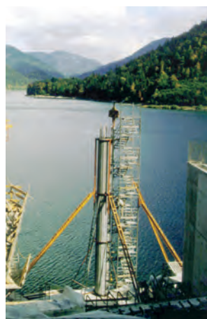
▼ Einschalung der Säulen ...
