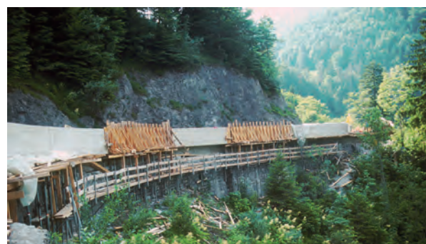
▲ ▼ Anpassung der Stützmauern an der Dammauffahrt
