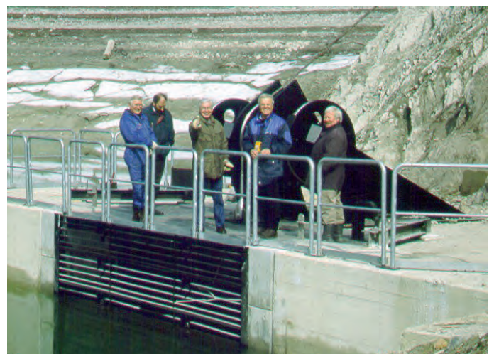
▲ Fertiger Revisionsverschluss - kurz vor Ostern 1999 konnte das Startsignal zum Wiederaufstau des Sees gegeben werden
