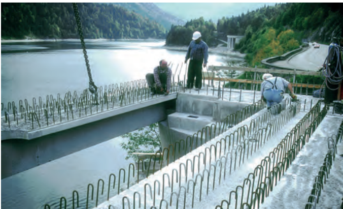
▲ Einbau von Fertigteilträgern für die neue Decke der Hochwasserentlastung
