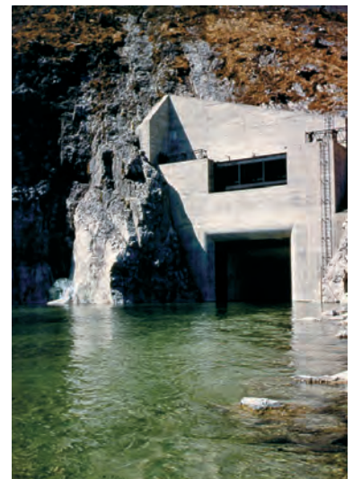
▶ Grundablass - Einlaufbauwerk mit verriegelter Revisionschütze
