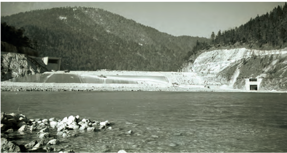
▲ Die Trockenlegung der Dammbaugrube wurde durch die Umleitung der Isar in den Grundablass- und Triebwasserstollen sowie durch den Vordamm gewährleistet
