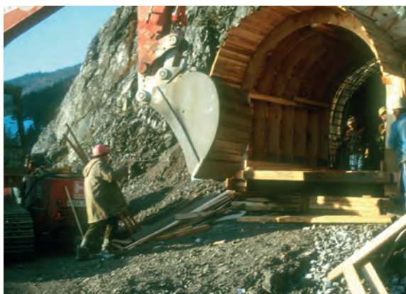
▲ Schalung am Stollenportal des Radweges
