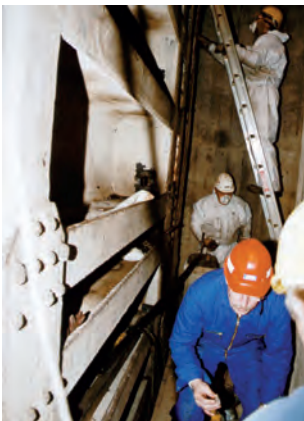
▲ Schützensanierung in Arbeit ...
