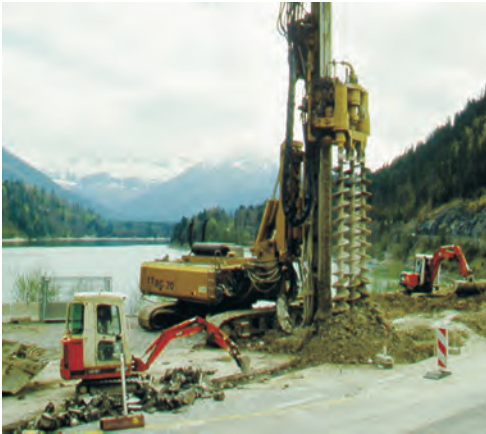
◀ Mixed-in-place Verfahren zum Anschluss der Kerndichtung
