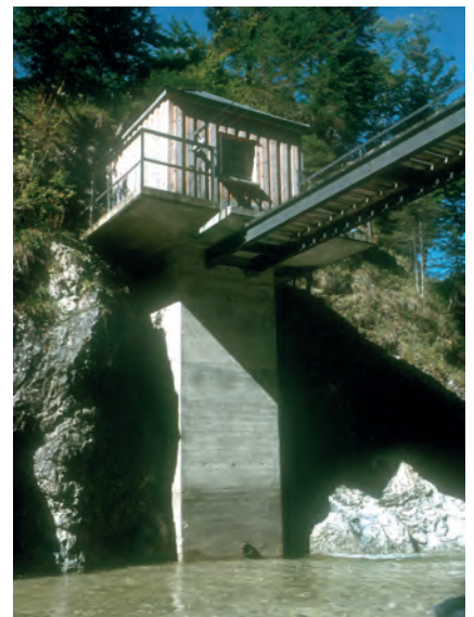
► Pegelanlage Dürrach - hier wird ein Zufluss zum Sylvensteinspeicher gemessen
