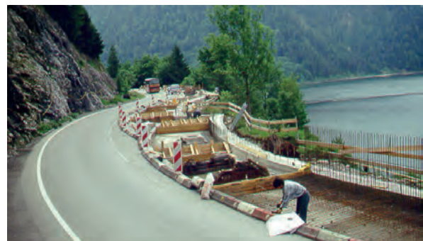
▲ ▼ Anpassung der Stützmauern an der Dammauffahrt
