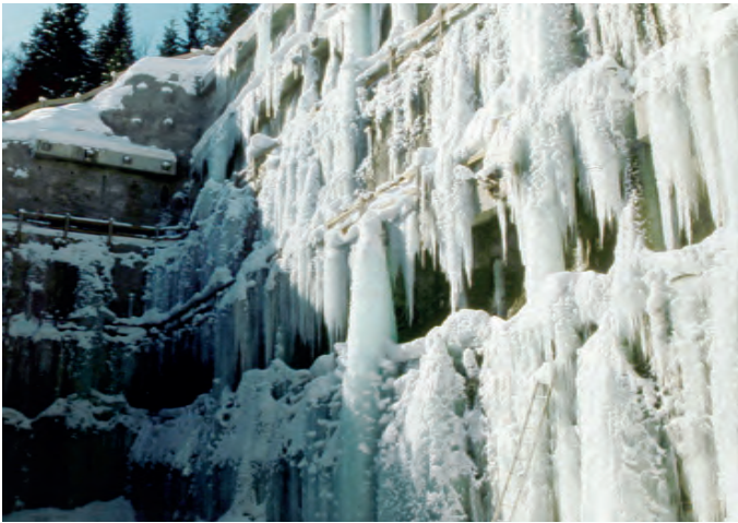
▲ Baugrube im Winter - das anstehende Bergwasser erstarzt zu riesigen Eiszapfen
