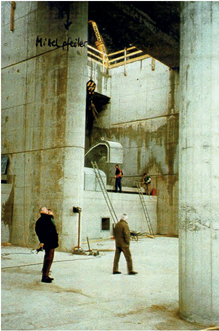
◀ Einsetzen der Überlaufschwelle
