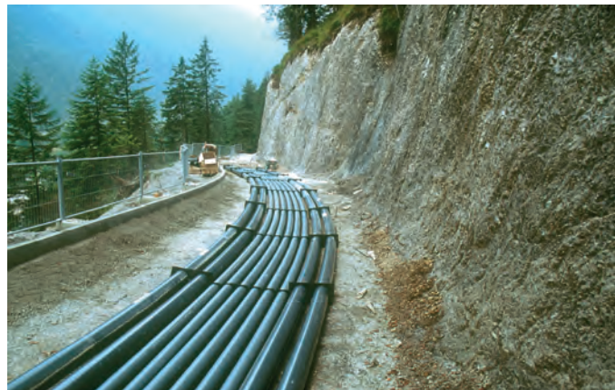
▲ Unter der Radwegfahrbahn wurden neue Versorgungsleitungen für den Speicher- und Kraftwerksbetrieb verlegt
