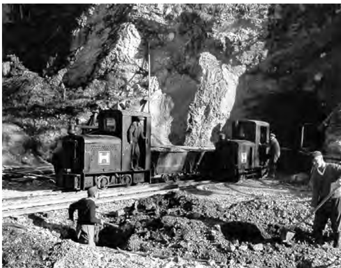
▲ Mit der Baubahn wurde das Ausbruchmaterial aus dem Stollen transportiert
