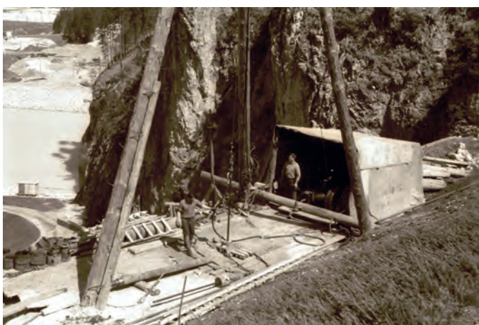
▼ Kontrollbohrungen zur Überprüfung der Dammichte
