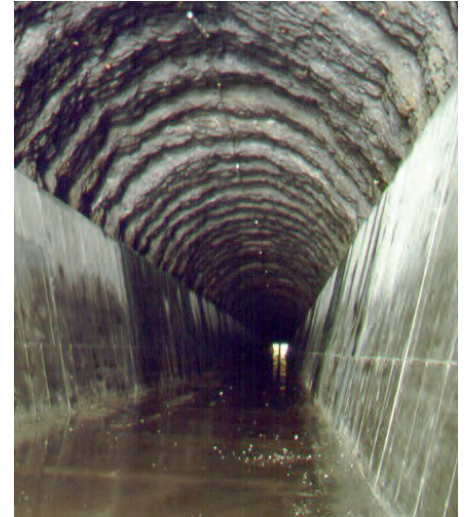
▶ Fertiger Stollen - Sohle und Seitenwände sind mit Beton verkleidet
