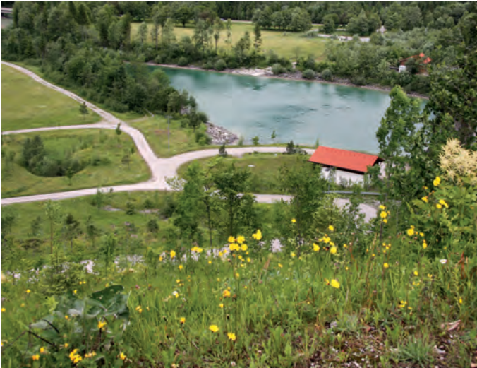
▲ Dammböschung zwischen Hennenköpfl und Sylvensteinfels mit Blick auf Wiese, Regenklärteich, Kraftwerkshaus und rechten Kolksee
