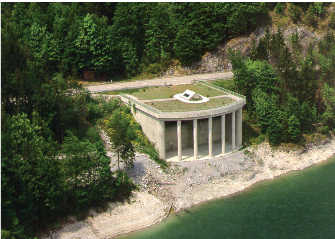
◀ Fertige Plattform des Einlaufbauwerkes der neuen Hochwasserentlastung
