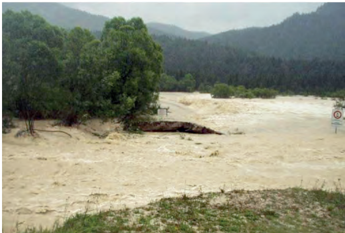
▲ Gebrochene Geschiebesperre am Isarzufluss zum Sylvensteinspeicher am 23.08.2005
