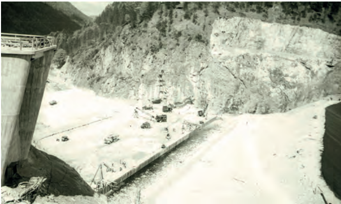
▲ Dammbaugrube, Gründung des Dichtungskerns
