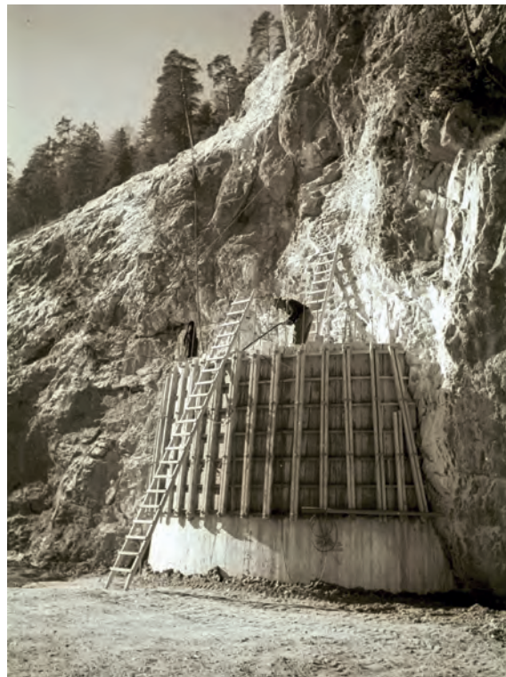
◀ Der Vorsatzpfeiler gleicht den vorspringenden Felsüberhang aus. Im Steigschacht sind Messeinrichtungen untergebracht ▶
