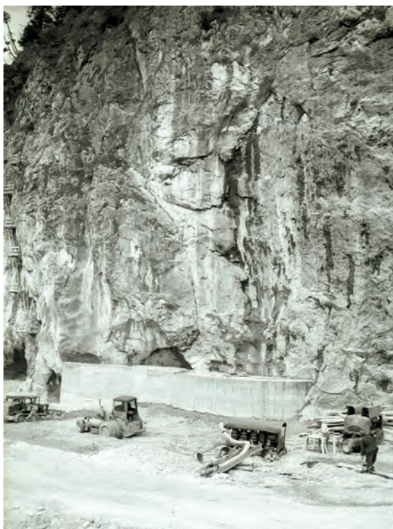
◀ Der Vorsatzpfeiler gleicht den vorspringenden Felsüberhang aus. Im Steigschacht sind Messeinrichtungen untergebracht ▶
