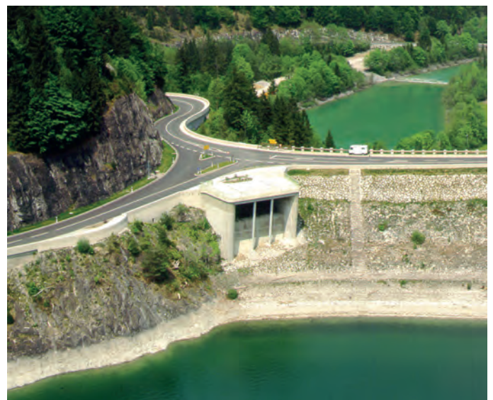
▲ Heutiger Zustand der alten Hochwasserentlastung
