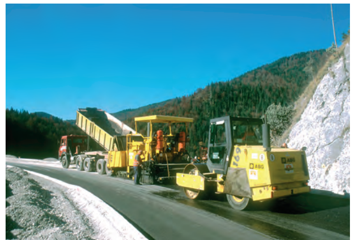
▲ Einbau der neuen Straßendecke auf der Dammkrone
