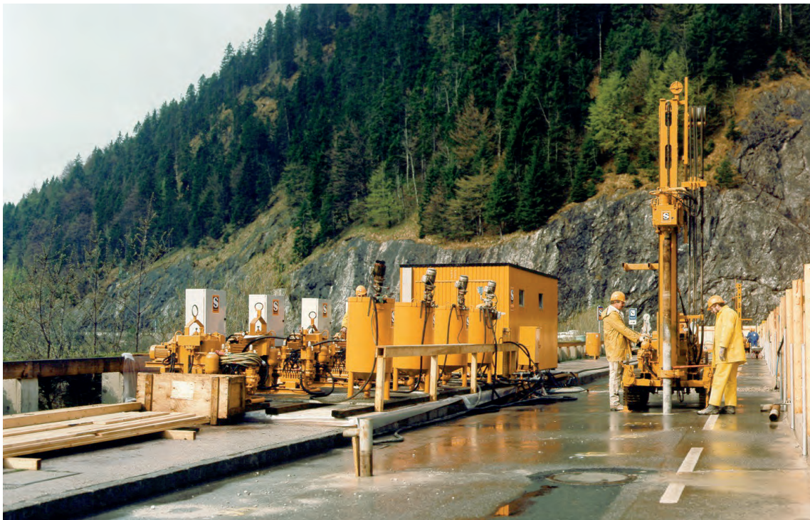
◀ Injektionsstation mit Bohrerät, Mischanlagen, Druckpumpen und Kontrolleinrichtungen auf der Dammkrone
