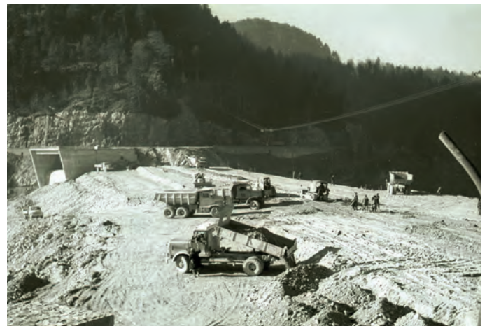
▲ Die Dammschüttung wurde im Zweischichtbetrieb Tag und Nacht durchgeführt
