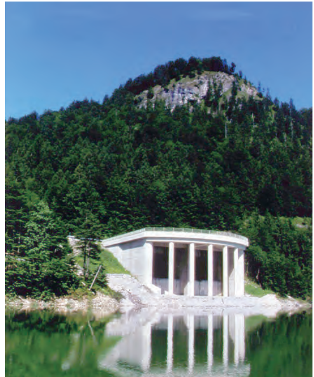
▲ Fertiges Einlaufbauwerk - im Volksmund "Tempel am Sylvenstein" genannt
