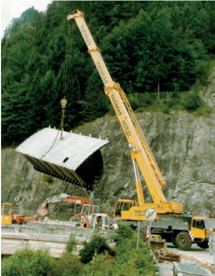
◀ Ausbau des Drumgates
