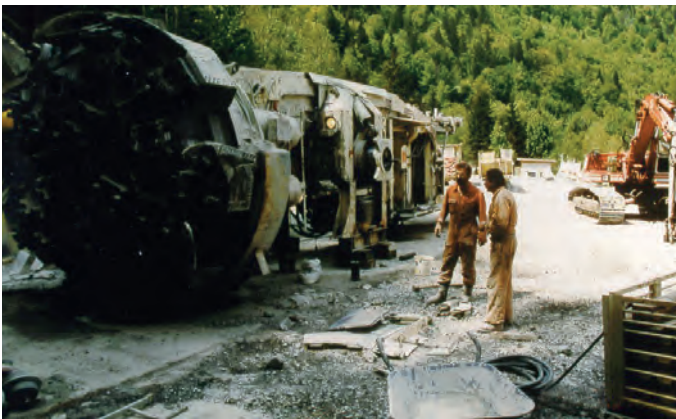
▲ Tunnel-Bohrmaschine mit Bohrkopf, 3,50 m Durchmesser. Mit ihr wurde der Pilotstollen gefräst
