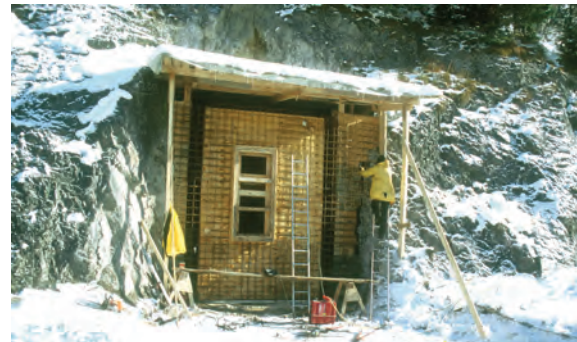
▲ Erhöhung und Sanierung des Speicherpegelhauses
