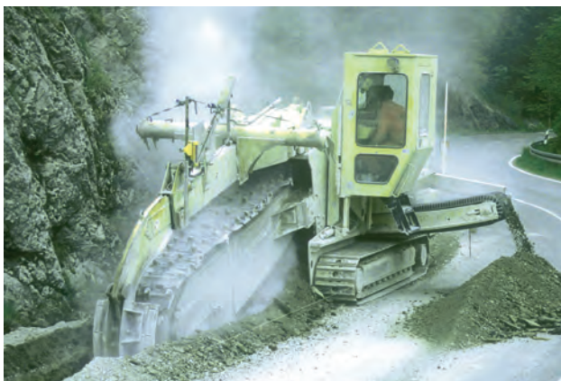
▲ Ausfräsen eines Grabens entlang der Bundesstraße für die Entwässerungsleitung
