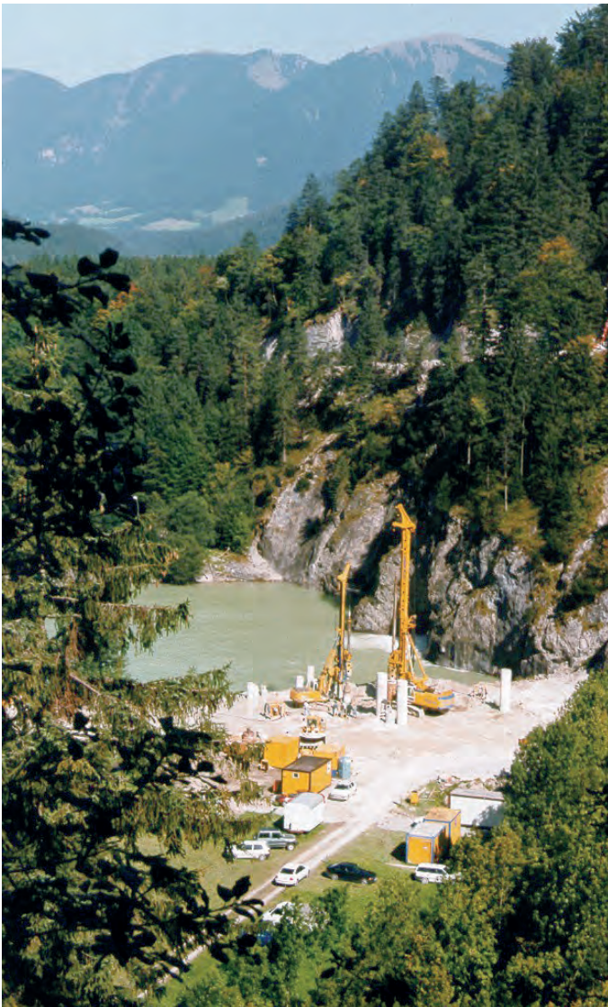
▲ Baustellenübersicht - Herstellen der Bohrpfahlwand
