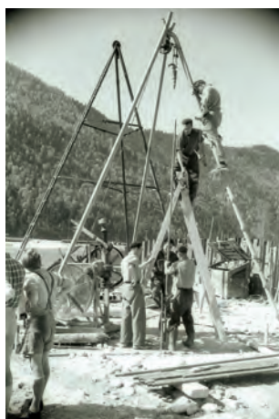
▲ Injektionsbohrungen zur Abdichtung des Untergrundes
