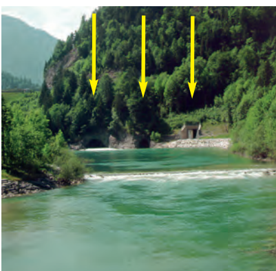
◀ Fertiges Auslaufbauwerk - links die Auslässe des Grundablasses und der alten Hochwasserentlastung
