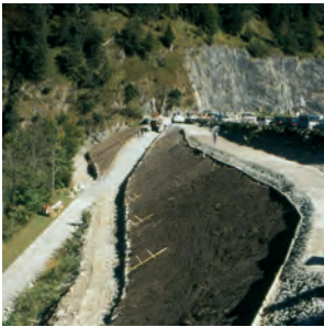
◀ Oberste Dammböschung nach Abschluss der Baumaßnahmen und Auftrag von Humus 1997
