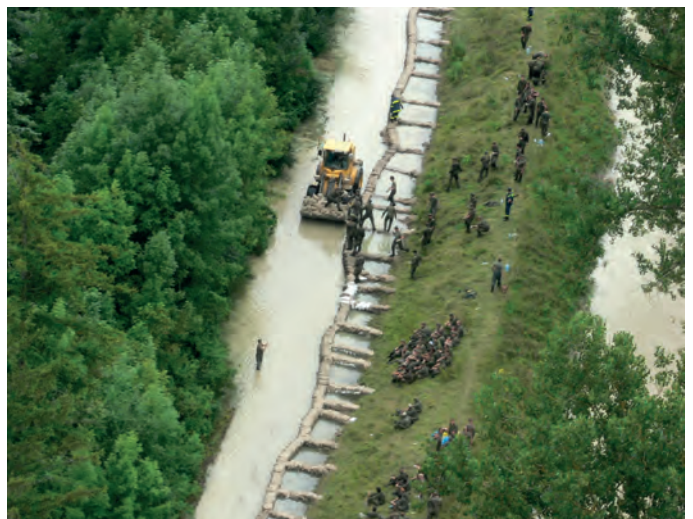
▲ Verteidigung der Isardeiche bei Eitting / Bereich Freising
