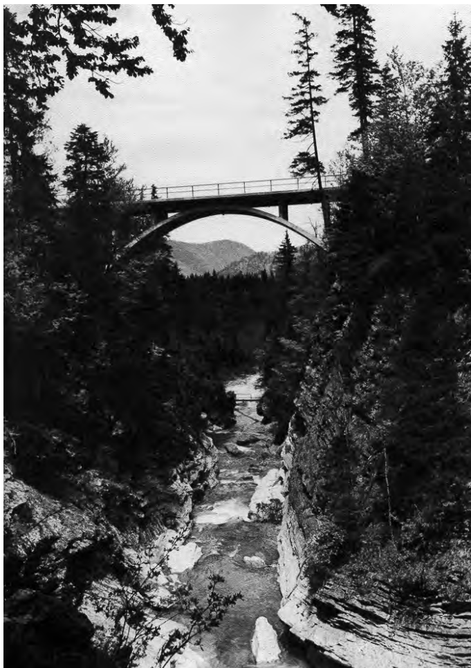
▲ Fertige Brücke über die Dürrachklamm
