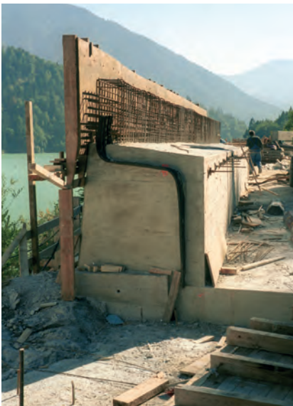
◀ Stützmauerprofil
