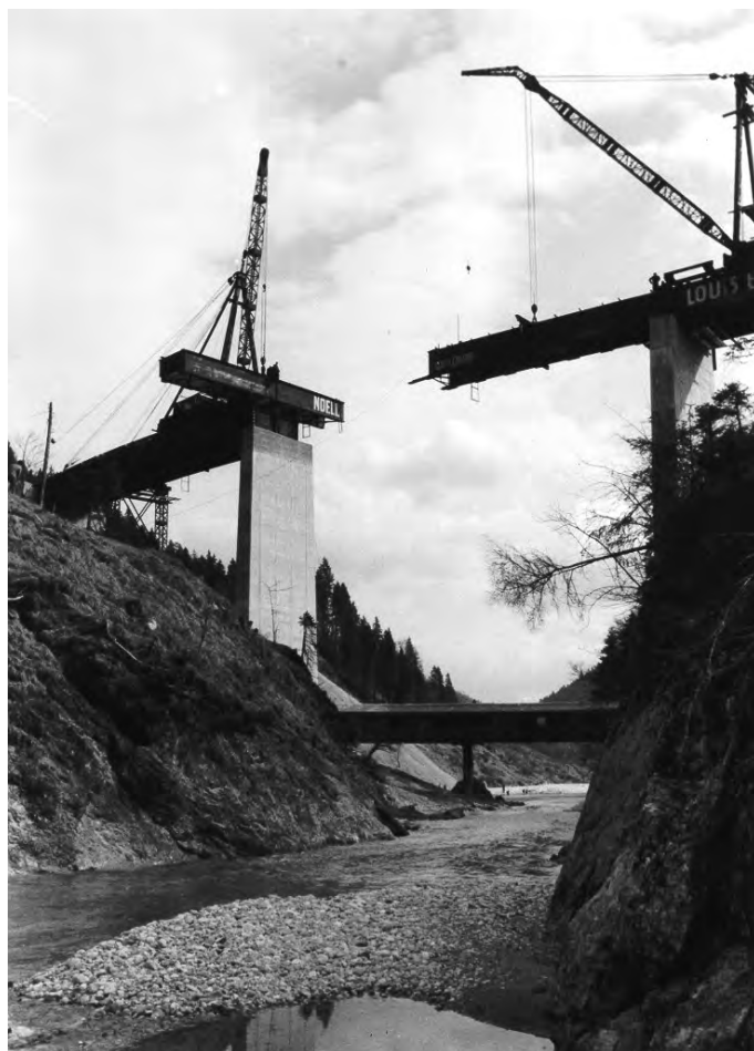
▲ Arbeitskräne fügen, hoch über der Grindelbrücke, die Fahrbahnträger der Faller-Klammbrücke zusammen
