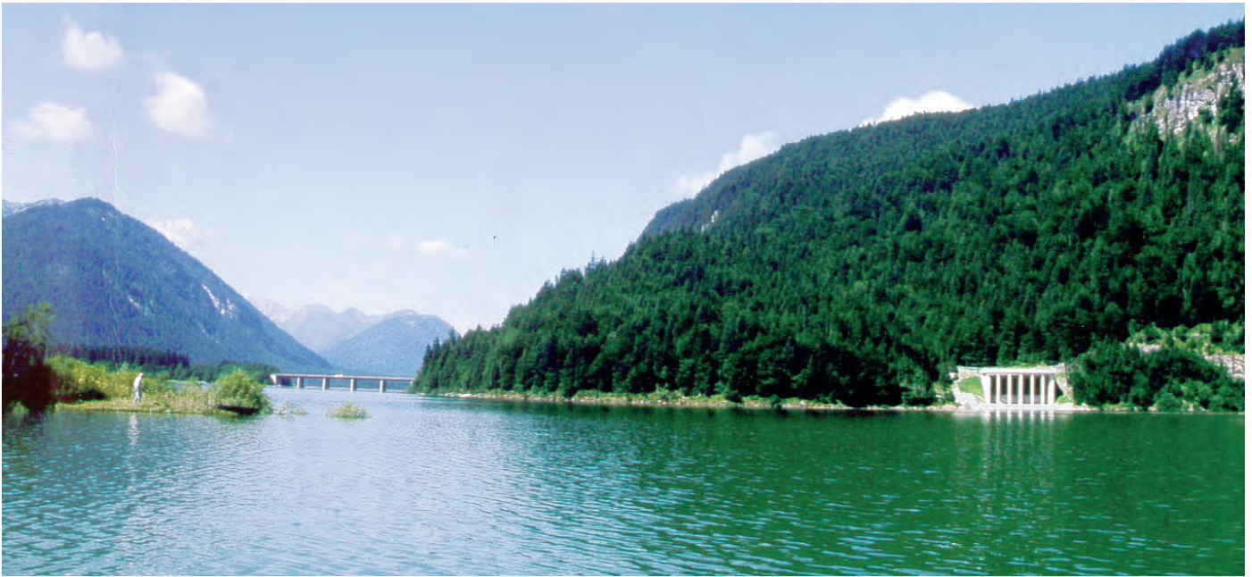
▲ Das Einlaufbauwerk der neuen Hochwasserentlastung ist in einer kleinen Bucht vor direkter Anströmung geschützt
