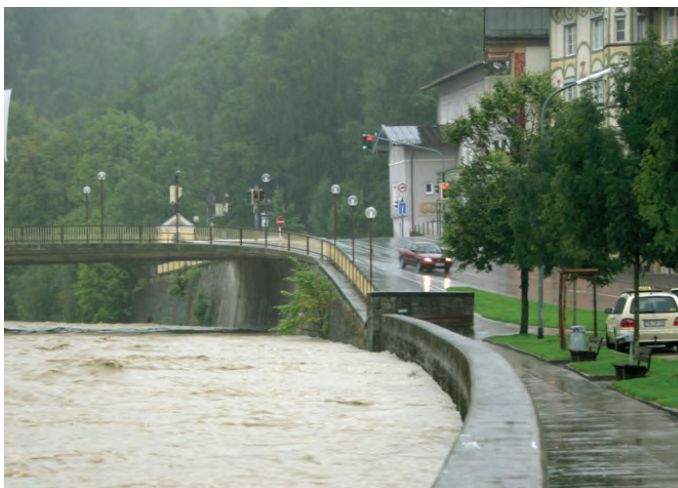
◀ Hochwasserabfluss in Bad Tölz am 23.08.05 um 14.00 Uhr mit ca. 475 m 3 /s und 80 cm Freibord
