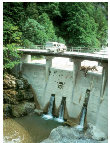
► Dürrach-Geschiebesperre am Stierschlag, eine 20 m hohe Bogenstaumauer mit Wasserdurchlässen
