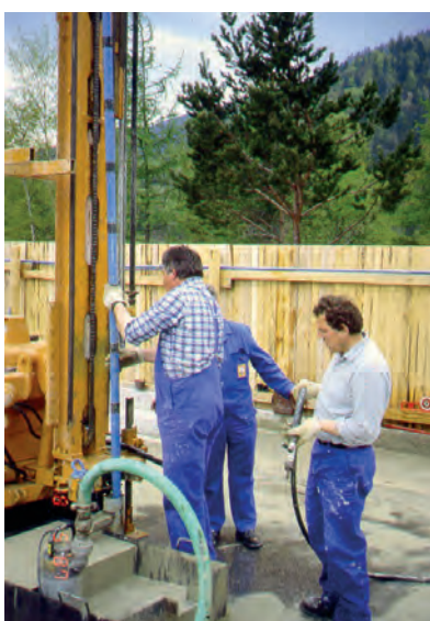
◀ Einführung der Manschettenrohre zur Verpressung des Dichtungskerns
