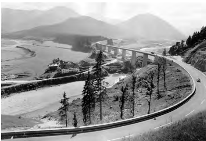
▲ Noch stehen die Häuser von Alt-Fall, doch daneben steht bereits die neue Klammbrücke
