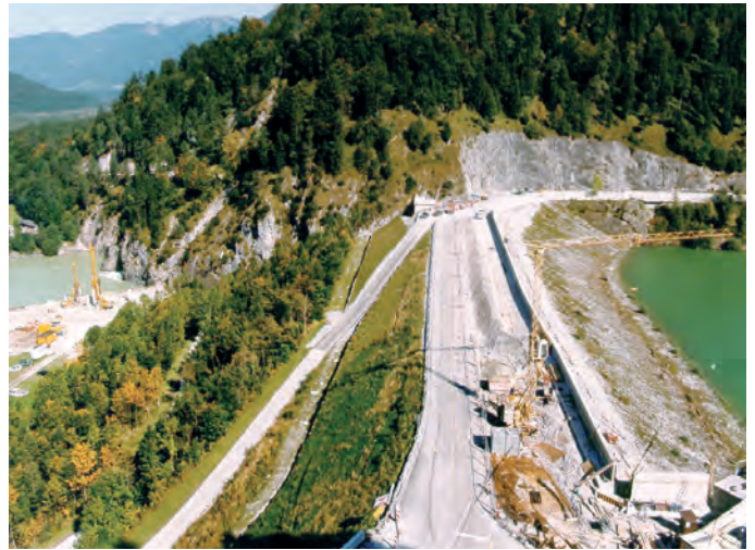
▲ Bau der Kronenmauer
