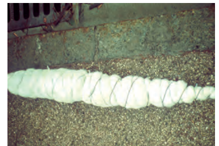
▲ Einbau neuer Porenwasserdruck-Sonden in Bohrlöcher
