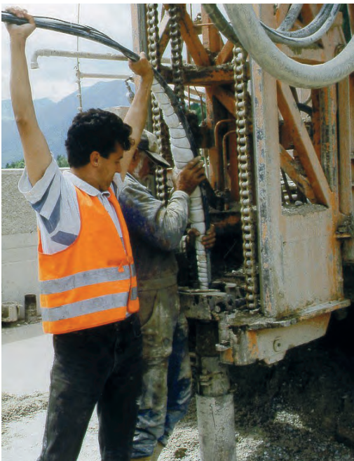
◀ Einbau einer Porenwasserdrucksonde
