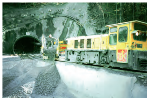
◀ Stollenbau - mit kleinen Waggons wurde der Felsausbruch aus dem Stollen transportiert
