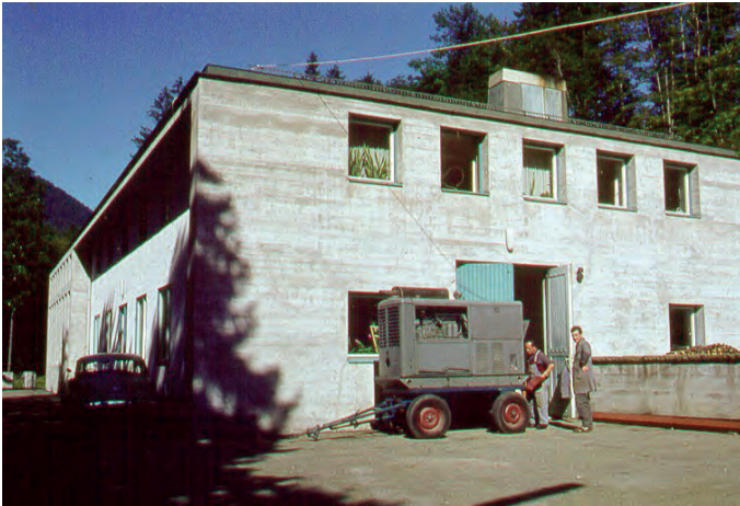
▲ Betriebsgebäude im alten Zustand
