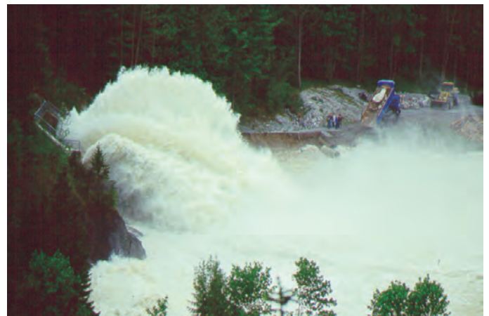
▲ Neue Hochwasserentlastung in Betrieb mit 260 m 3 /s
