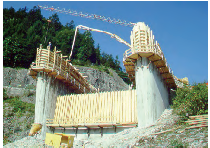
▲ Einlaufbauwerk - Ansicht von der Seeseite aus
