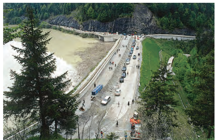
▲ Wesentliche Elemente der Dammerhöhung (Kronenmauer und Kerndichtung) standen beim Hochwasser bereits zur Verfügung
