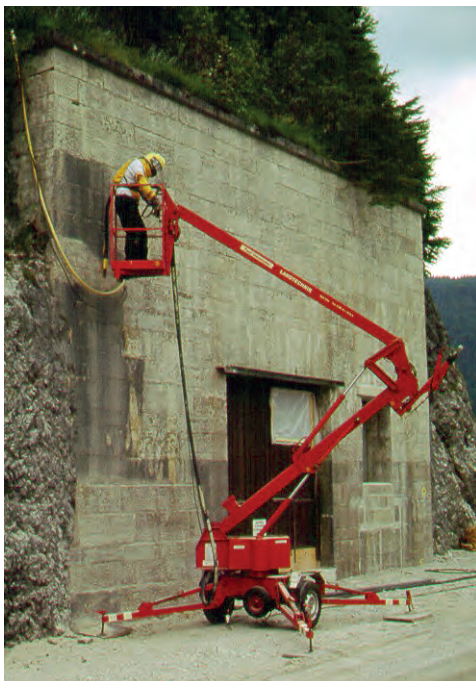
◀ Grundablass - Sanierung des Schieberschacht-Zuganges
