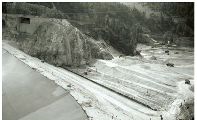
▲ Vordamm mit Asphaltabdichtung, Dammbaugrube und Hochwasserentlastung
