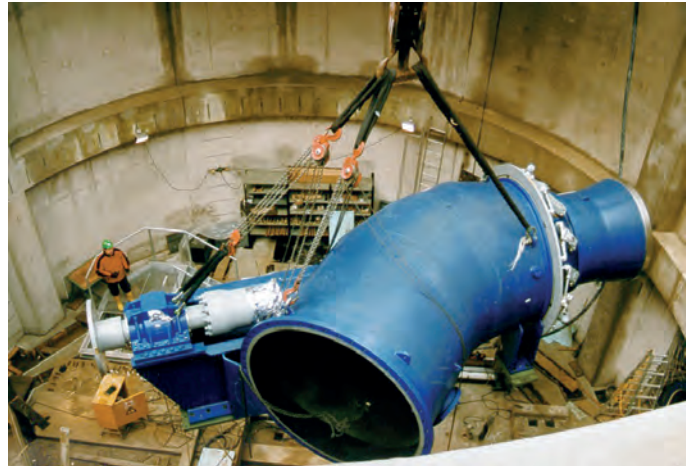
▲ Einbau der neuartigen Compact-Axial-Turbine
