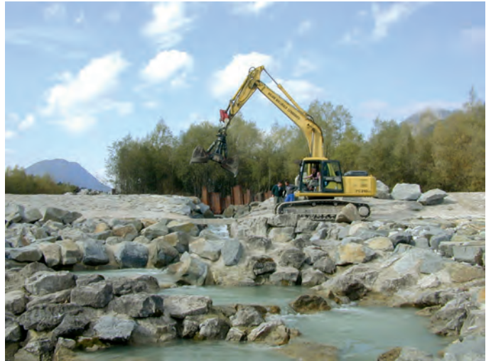
▲ Neubau der Fischaufstiegshilfe an der Geschiebesperre
