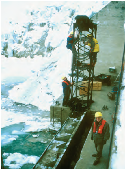
◀ Der alte Revisionsverschluss war oft nur unter schwierigen Bedingungen zu setzen
