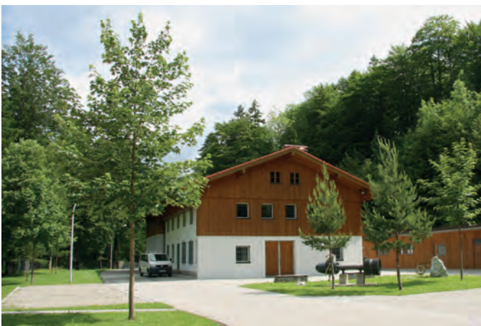
▲ Außenanlagen am Betriebshof – im Jahr 2003 neu gestaltet
