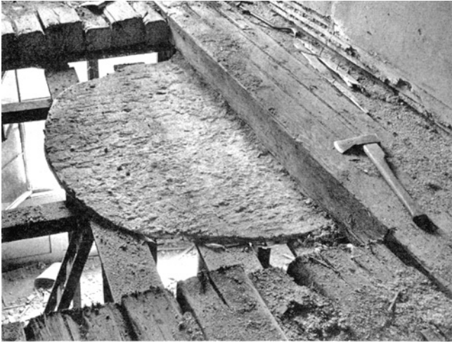
Bülach. Gasthaus «Zum goldenen Kopf». Gothestübli. Demontage des Deckengemäldes: Der südlichste Teil nach teilweiser Entfernung der Deckenbalken am 7. Juli 1964.
