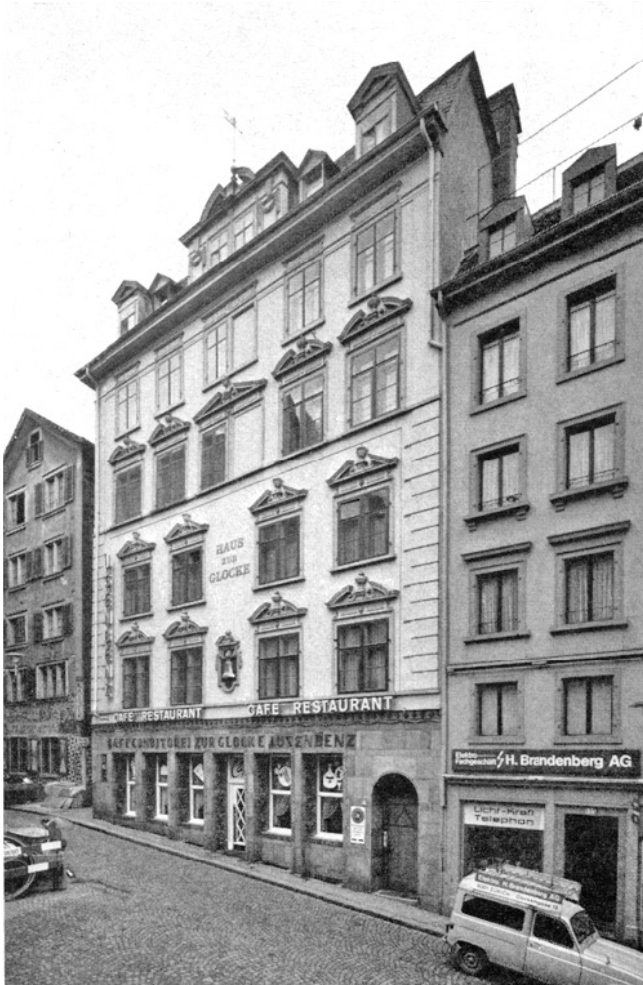
Glockengasse 9. Fassade nach der Renovation.
