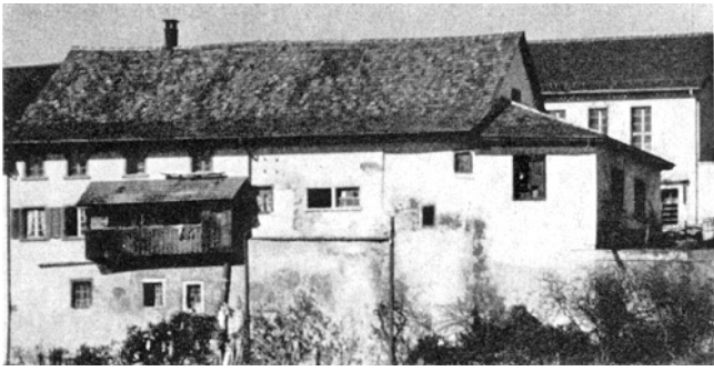
Regensburg. Unterburg. Ehemalige Kleinbauernhäuser Vers.-Nr. 10 und 11, abgebrochen 1967.
