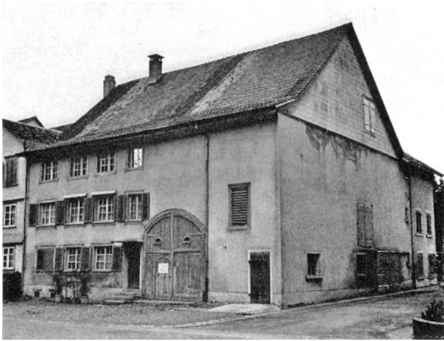
Elgg. Obergasse. Ehemaliges Bauernhaus Vers.-Nr. 273, abgebrochen 1966.
