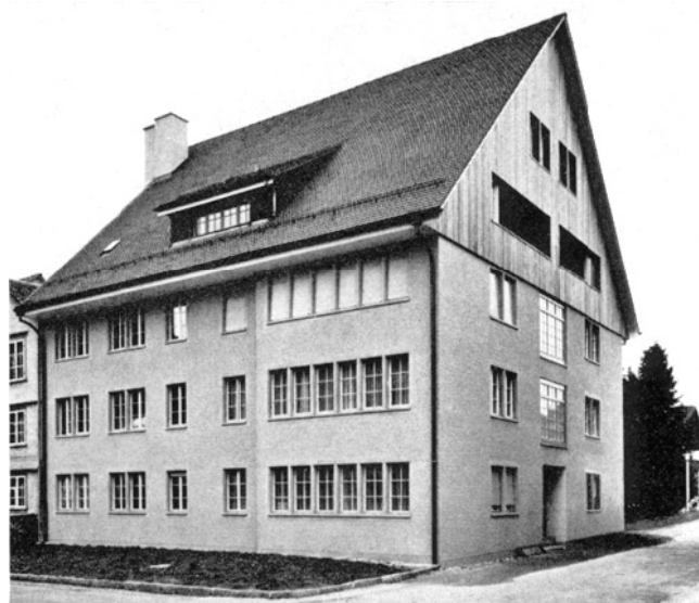
Elgg, Obergasse. Haus mit Alterswohnungen an der Stelle des ehemaligen Bauernhauses Vers.-Nr. 273, Neubau von 1966/67.
