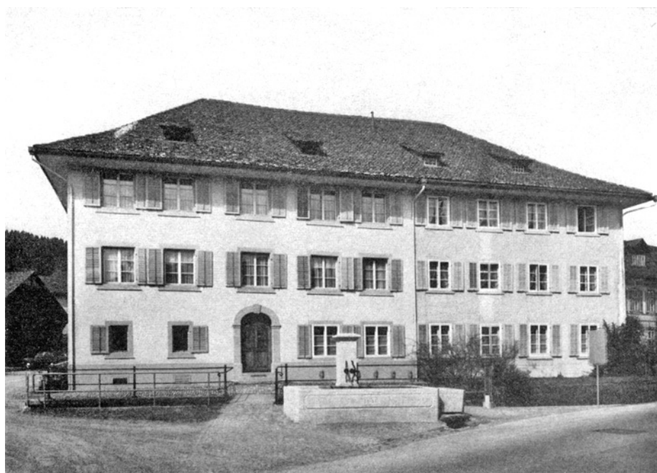
Wila. Reformiertes Pfarrhaus. Hauptfassade, nach der teilweisen Renovation 1965.
