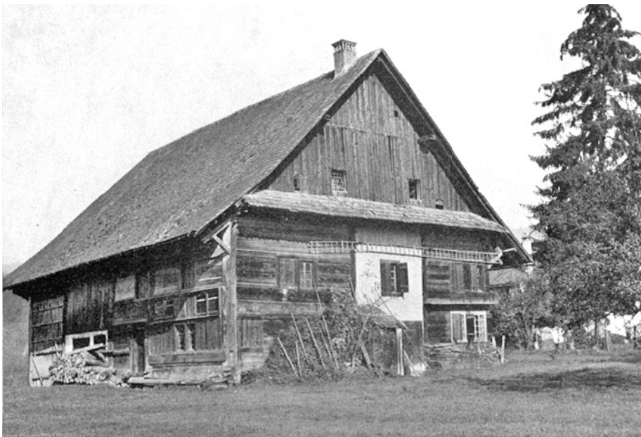
Mettmenstetten. Bahnhofstrasse. Ehemaliges Bauernhaus Hofstetter aus dem 17. Jahrhundert, abgebrochen 1965.
