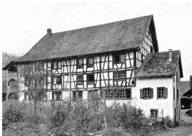
Langnau a. A. Rängg. Riegelhaus Vers.-Nr. 419. Südliche Traufseite vor der Renovation.
