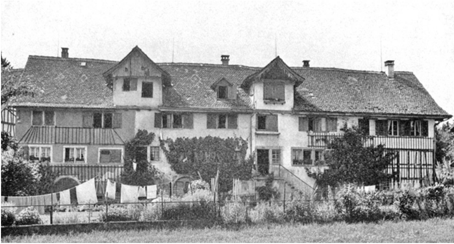
Meilen. Burg. Reihnhaus Vers.-Nr. 1040–1042. Rechts aussen Hausteil Vers.-Nr. 1042, vor dem Umbau von 1967
