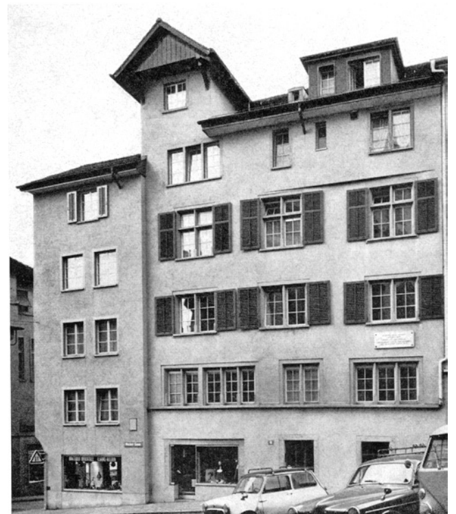
Glockengasse 18 und Augustinergasse 16. Das renovierte Haus «Zum grünen Schild» (rechts) und der Neubau des «Entli» (links).
