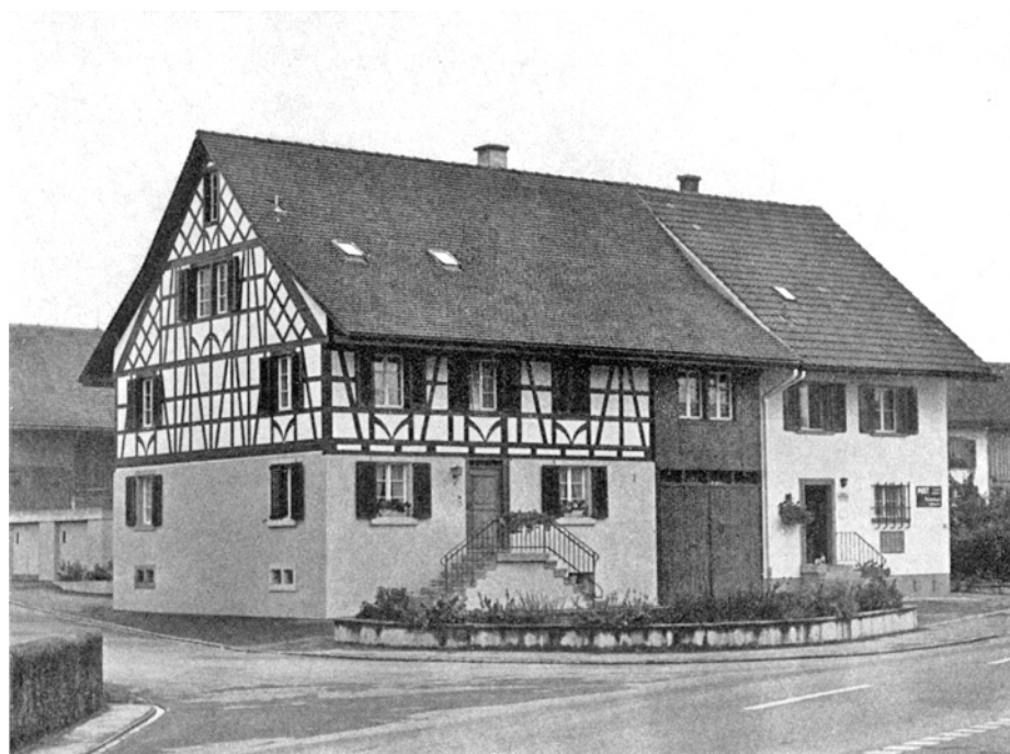
Rickenbach. Ehemaliges Bauernhaus Vers.-Nr. 44, nach dem Umbau.
