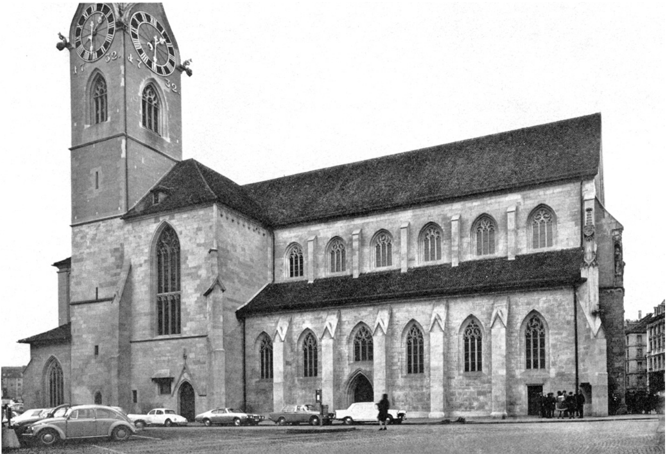
Fraumünster. Die restaurierte Nordfassade des Langhauses.
