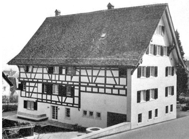
Dielsdorf. Reformiertes Pfarrhaus. Nordfassade nach der Restaurierung von 1967.
