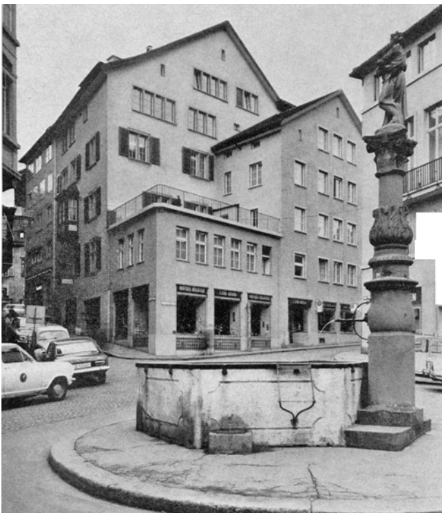
Glockengasse 18, Augustinergasse 16 und 18. Die Baugruppe vom Münzplatz aus gesehen, nach der Umgestaltung. Hinten das umgebaute Haus «Zum grünen Schild».
