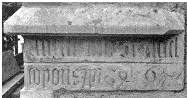
Neftenbach. Reformierte Kirche. «Grundstein» von 1466. Ostseite während der Renovation.
