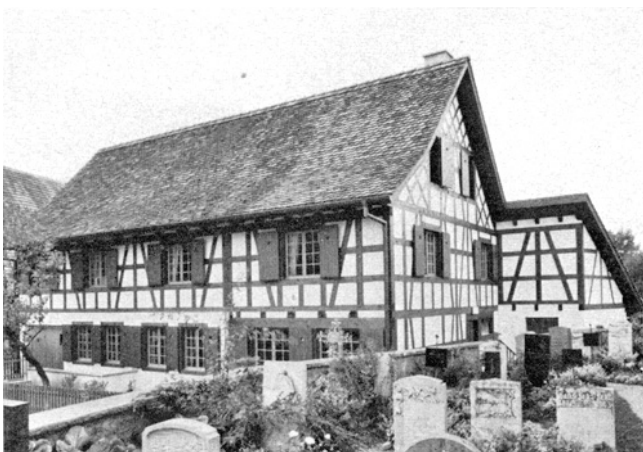
Berg a. I. Ehemaliges Bauernhaus Vers.-Nr. 74/75. Nach dem Umbau 1967.
