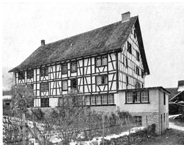
Langnau a. A. Oberrängg. Riegelhaus Vers.-Nr. 419. Südliche Traufseite nach der Renovation (mit leider unpassenden Fenstern).
