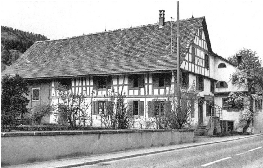
Stadel. Im Bühl. Sogenanntes «Doktorhaus» Vers.-Nr. 132, vor dem Umbau von 1967/69.
