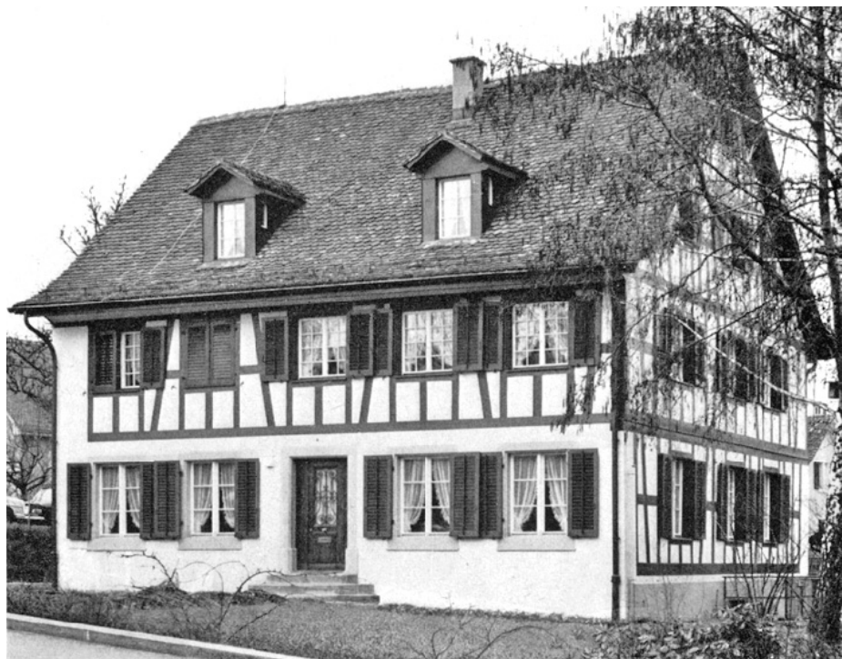
Altstetten. Pfarrhausstrasse 10. Pfarrhaus Altstetten nach der Renovation.
