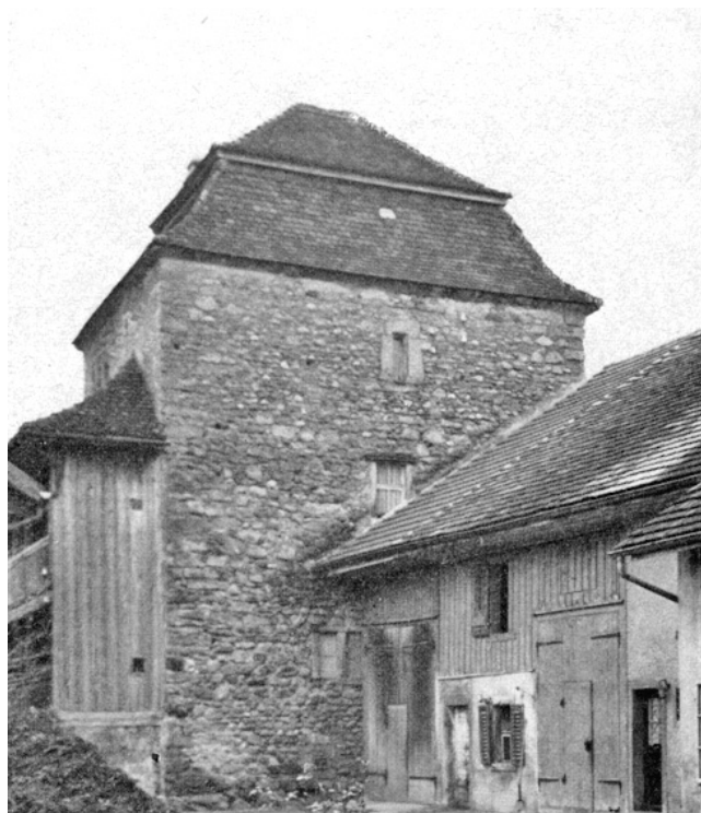
Wiesendangen. Schloss. (Wohnturm). Nordwestansicht. Vor der Restaurierung.
