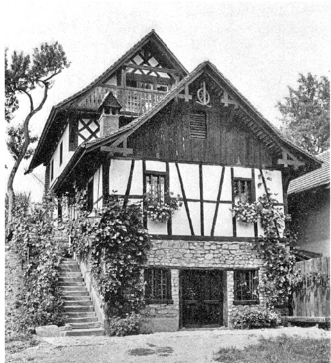
Stadel. Windlach. Ehemaliger Doppelspeicher Vers.-Nr. 353, nach der Renovation.
