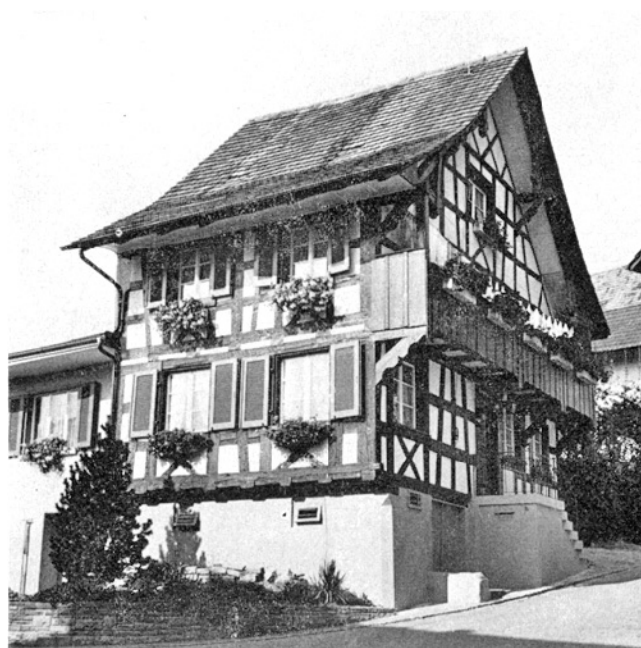
Hüntwangen. Haus Vers.-Nr. 63. Nach der Renovation.
