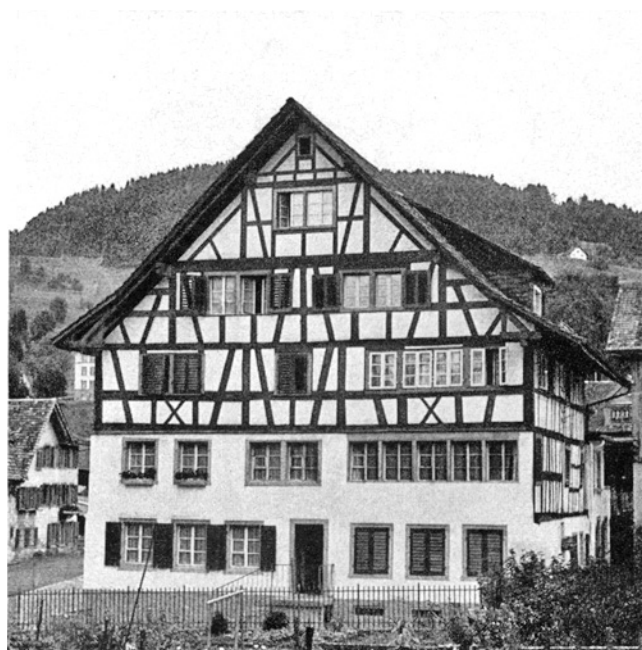
Wald, Unter-Punt. Haus Vers.-Nr. 1553, nach der Renovation.
