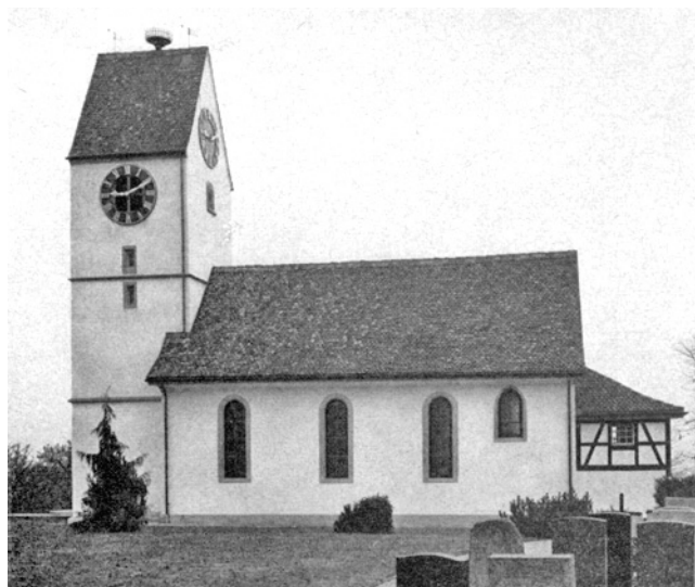
Buchs. Reformierte Kirche. Nordfassade nach der Restaurierung.
