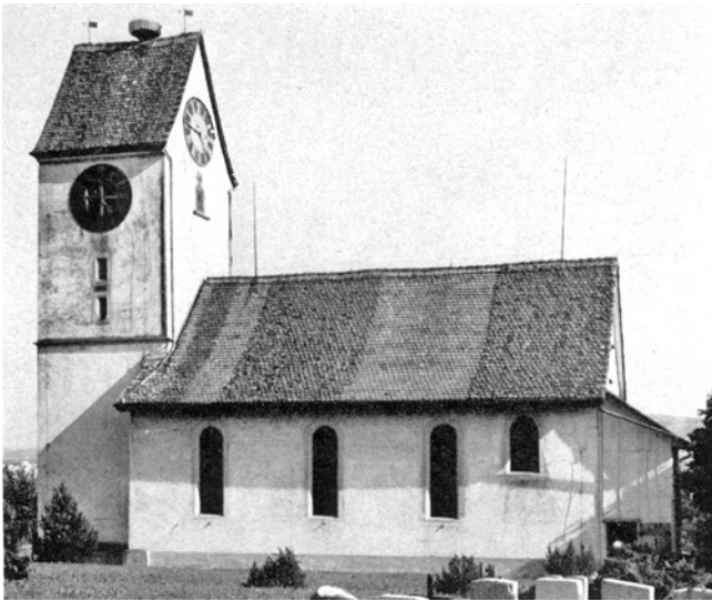
Buchs. Reformierte Kirche. Nordfassade vor der Restaurierung.
