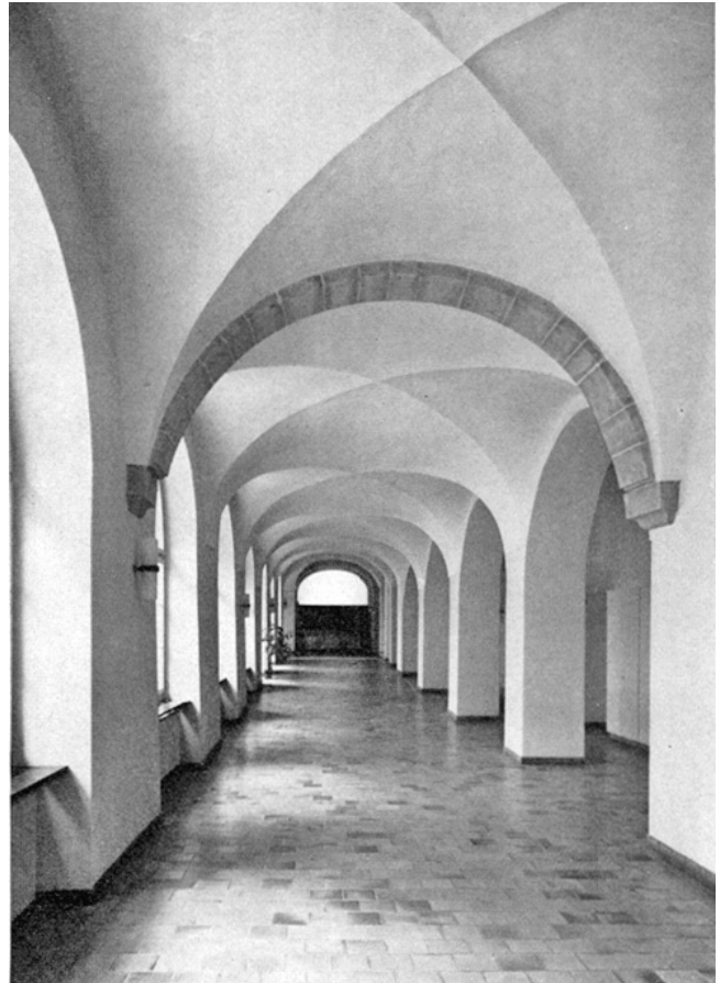
Rheinau. Ehemaliger Konvent. Barocker Kreuzgang. Südflügel, nach der Renovation 1967/68.
