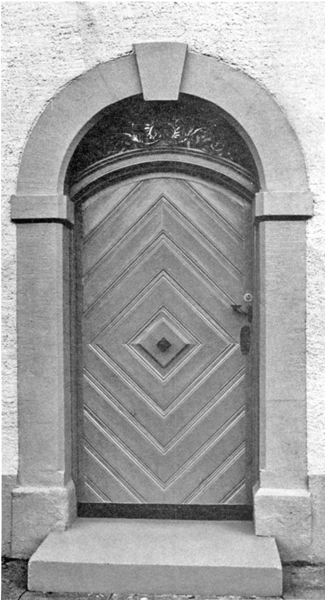
Wila. Reformiertes Pfarrhaus. Rückseitiges Portal. Nach der Renovation von 1965.
