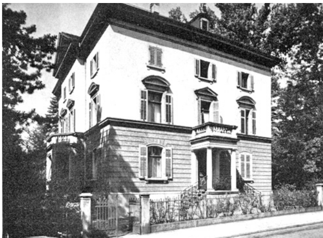
Wohnhaus Freiestrasse 36. Erbaut 1888 für Obergerichtsschreiber Dr. Emil Wuhrmann, vielleicht von Architekt Ernst Diener (1847–1927). Abgebrochen 1967.
