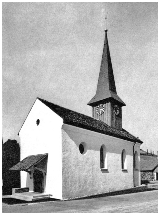
Dorf. Reformierte Kirche. Äusseres nach der Restaurierung.
