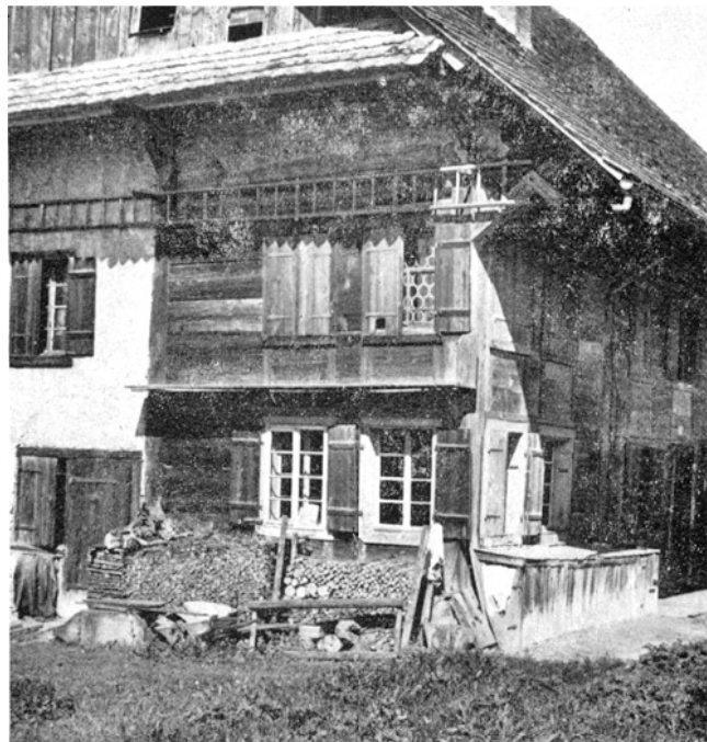
Mettmenstetten. Bahnhofstrasse. Ehemaliges Bauernhaus Hofstetter. Detail der Ostseite.
