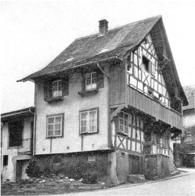
Hüntwangen. Haus Vers.-Nr. 63. Vor der Renovation.
