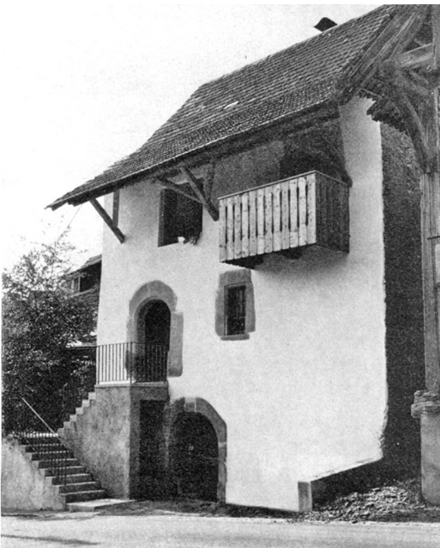
Schöfflisdorf. Ehemaliger Speicher von 1604, nach der Renovation.
