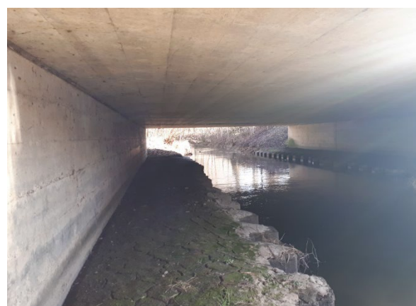
18) Gewässerdurchlass mit Bankett beim Haslibach entlang Dielsdorferstrasse
