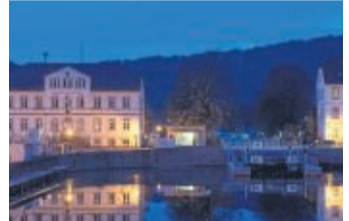
Unser Foto entstand am Abend zur blauen Stunde. Zu sehen sind auch Teile der neuen Steganlage, an der noch gebaut wird.
